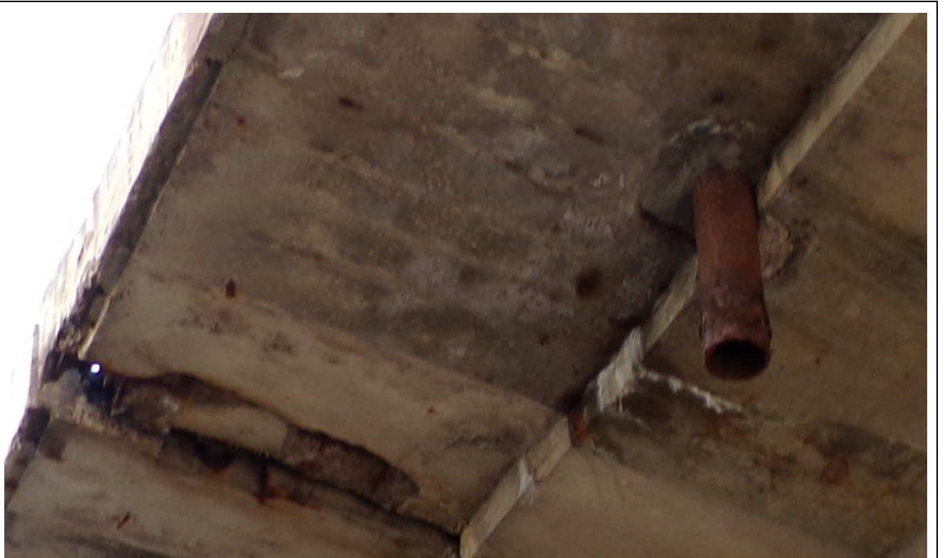
28 pav. Šulinėliai per trumpi ir sukorodavę, ties šulinėliais ir po šaltiličiu nesandari hidroizoliacija. Apiręs šaltiličio gembės galas ties deformaciniu pjūviu. Vaizdas „B“ sijoje ties I atrama
