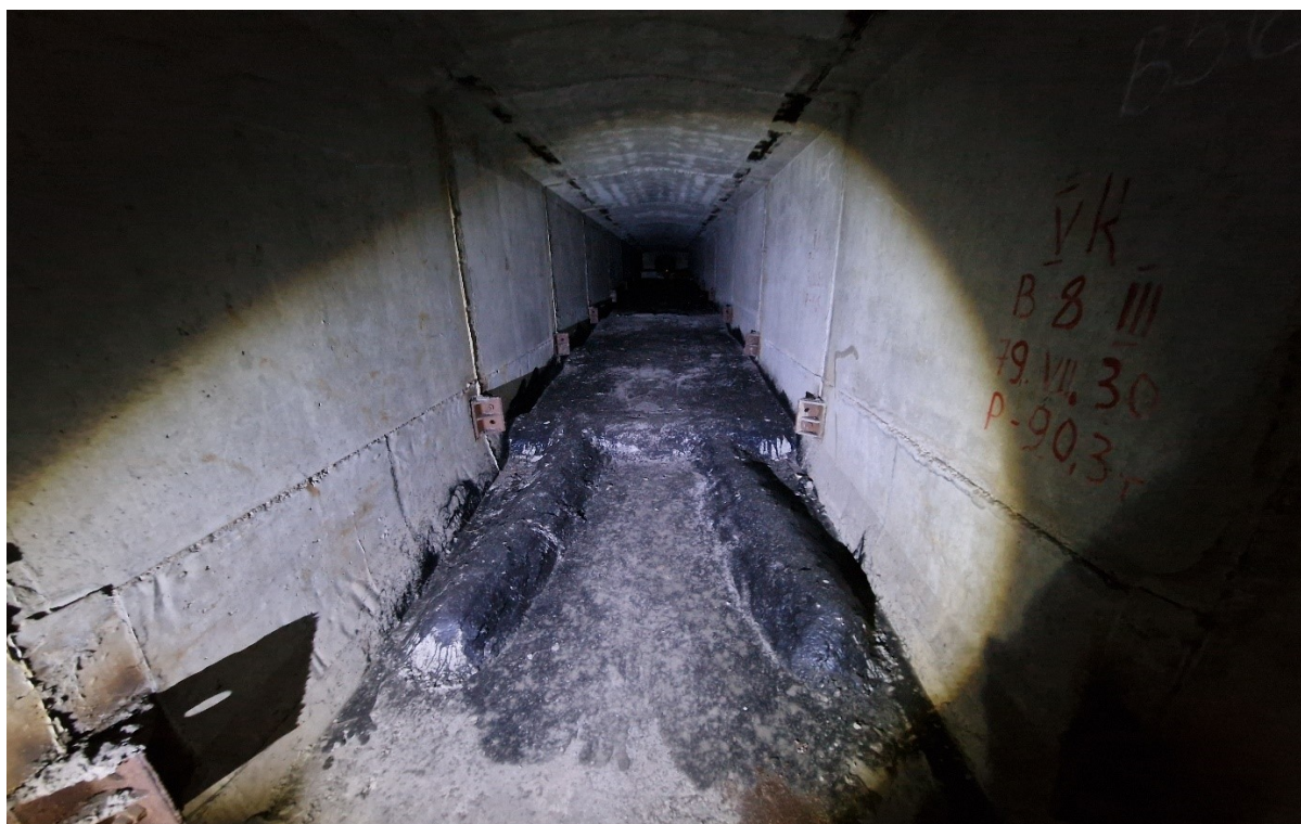
138 pav. „A“ sijoje įtemptos armatūros išdėstymas žiūrint nuo A56 bloko. Apžiūros metu defektų neužfiksuota, įtemptos armatūros apsauginis betonas padengtas bitumu
