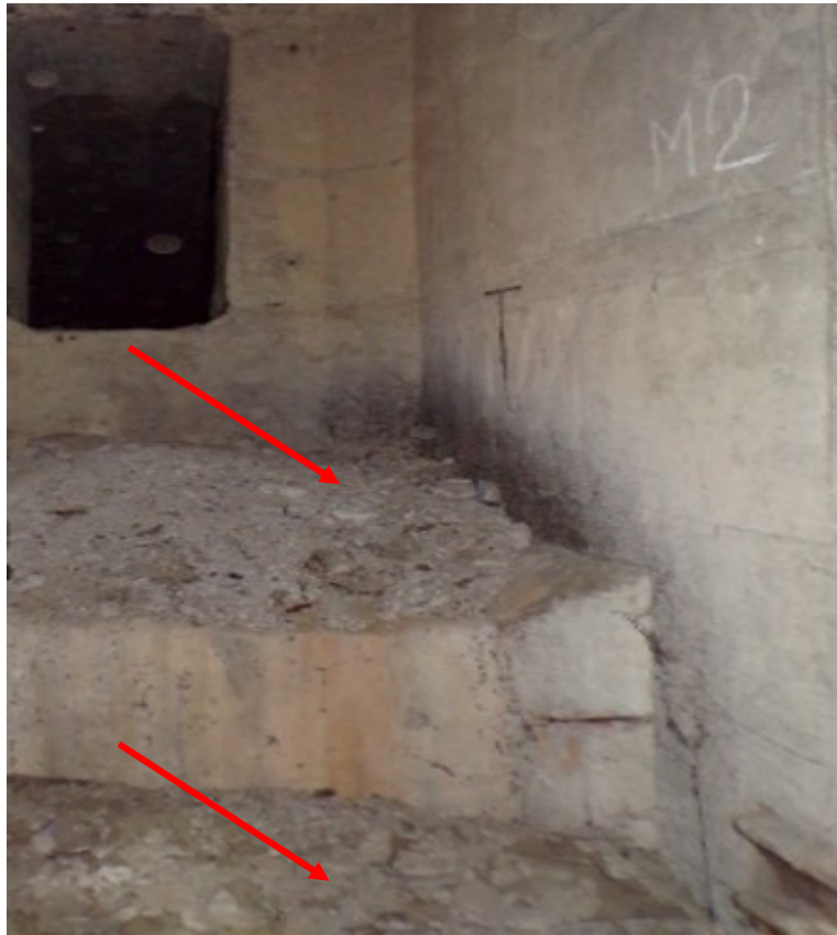
35 pav. Betono šiukšlių dvi krūvos „A“ sijos viduje ties V atrama
