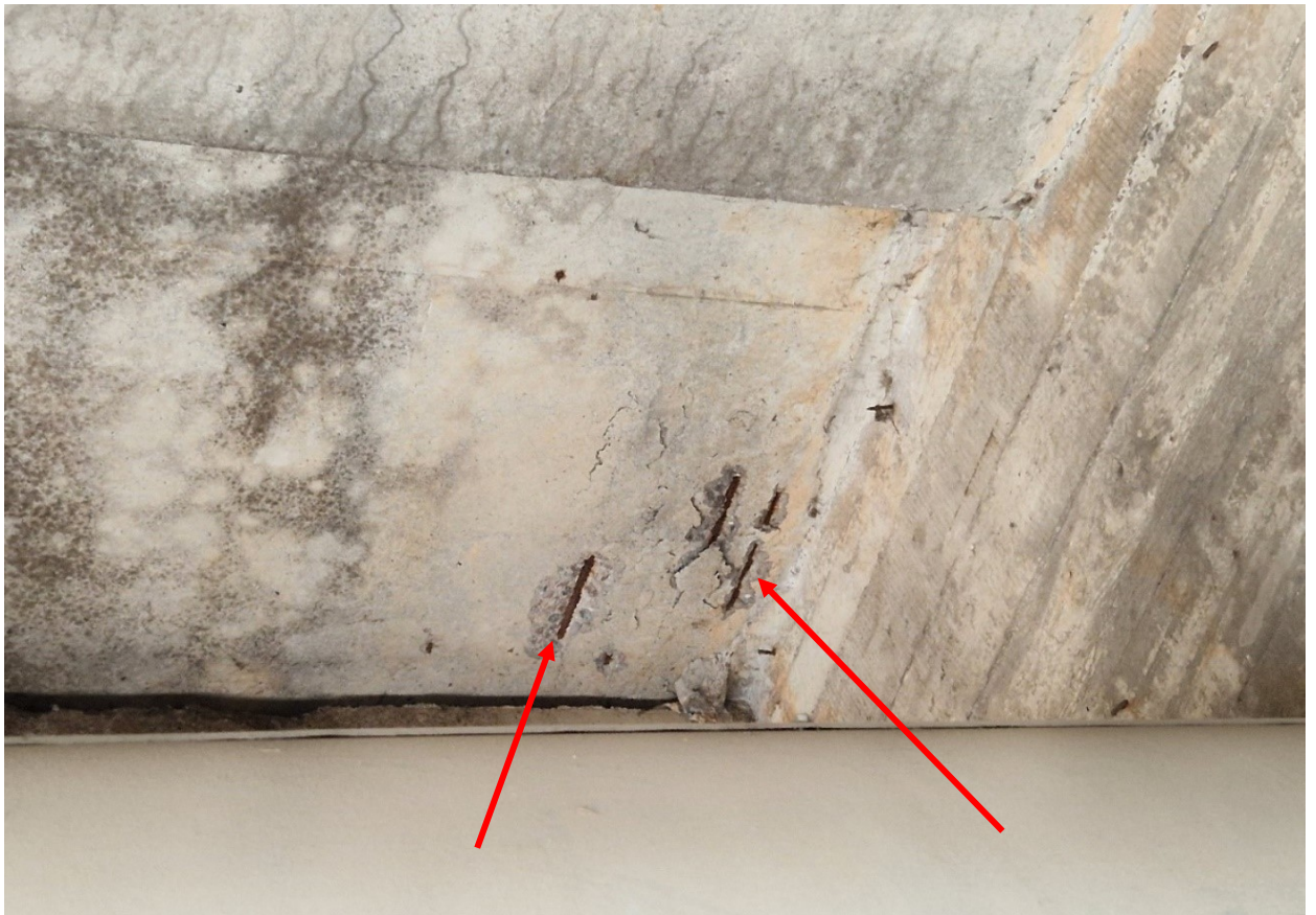
45 pav. Perdangos plokščių, įrengtų virš dėžinio skerspjūvio blokų lentynų, lokaliuose vietose atsokęs ir nukritęs apsauginis betono sluoksnis, koroduoja į paviršių išlindę armatūros strypai
