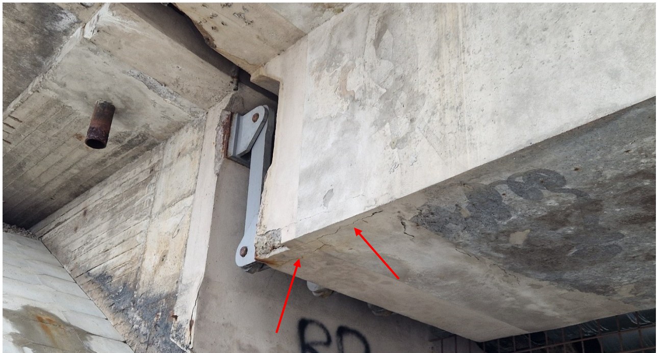
245 pav. „B“ sija žemupio pusė. Paslankus lankstas ties 6 atrama. Lanksto apačioje papleišėjęs sijos betonas, palei bloko kraštą atskilęs apsauginis betono sluoksnis, koroduoja į paviršių išlindę armatūros strypai, lokaliai pradeda koroduoti lankstų metaliniai elementai
