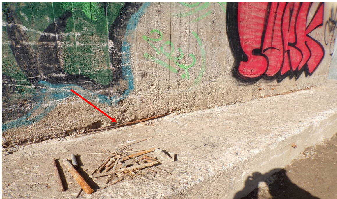
55 pav. Ketvirtos atramos liemens ir rostverko sandūroje (nuo upės pusės) ištrupėjęs apsauginis betono sluoksnis, koroduoja į paviršių išlindę armatūros strypai
