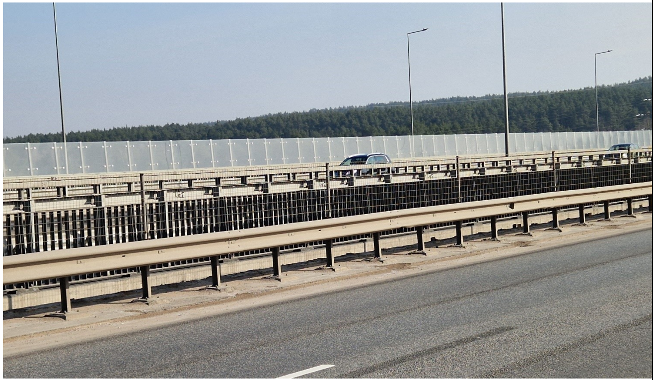
20 pav. Šaltilčio bendri vaizdai aukščiau pusėje. Daugelyje vietų šaltilčio kraštai apirę, paviršiai užteršti purvu
