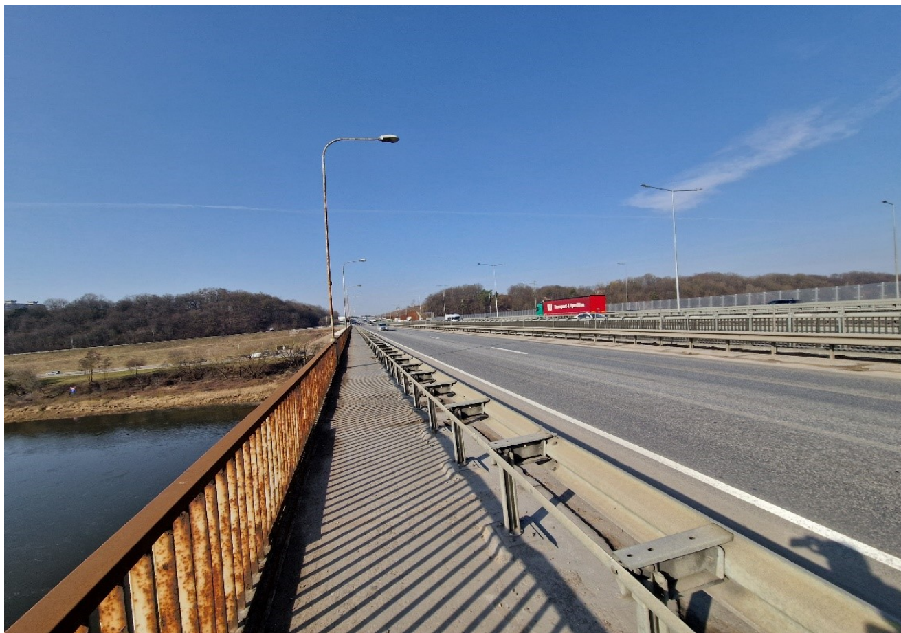
24 pav. Turėklų bendras vaizdas žemupio pusėje. Visi metaliniai elementai stipriai pažeisti korozijos, bendra turėklų būklė yra bloga
