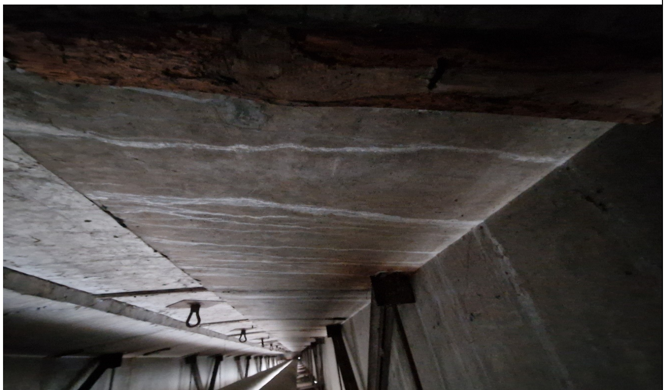
10 pav. Nesandari hidroizoliacija virš perdangos. III tarpatramio perdangos „A“ sijos blokų lentynose matyti išsisunkę karbonatiniai produktai, pataikai nubėgę ir ant blokų sienučių
