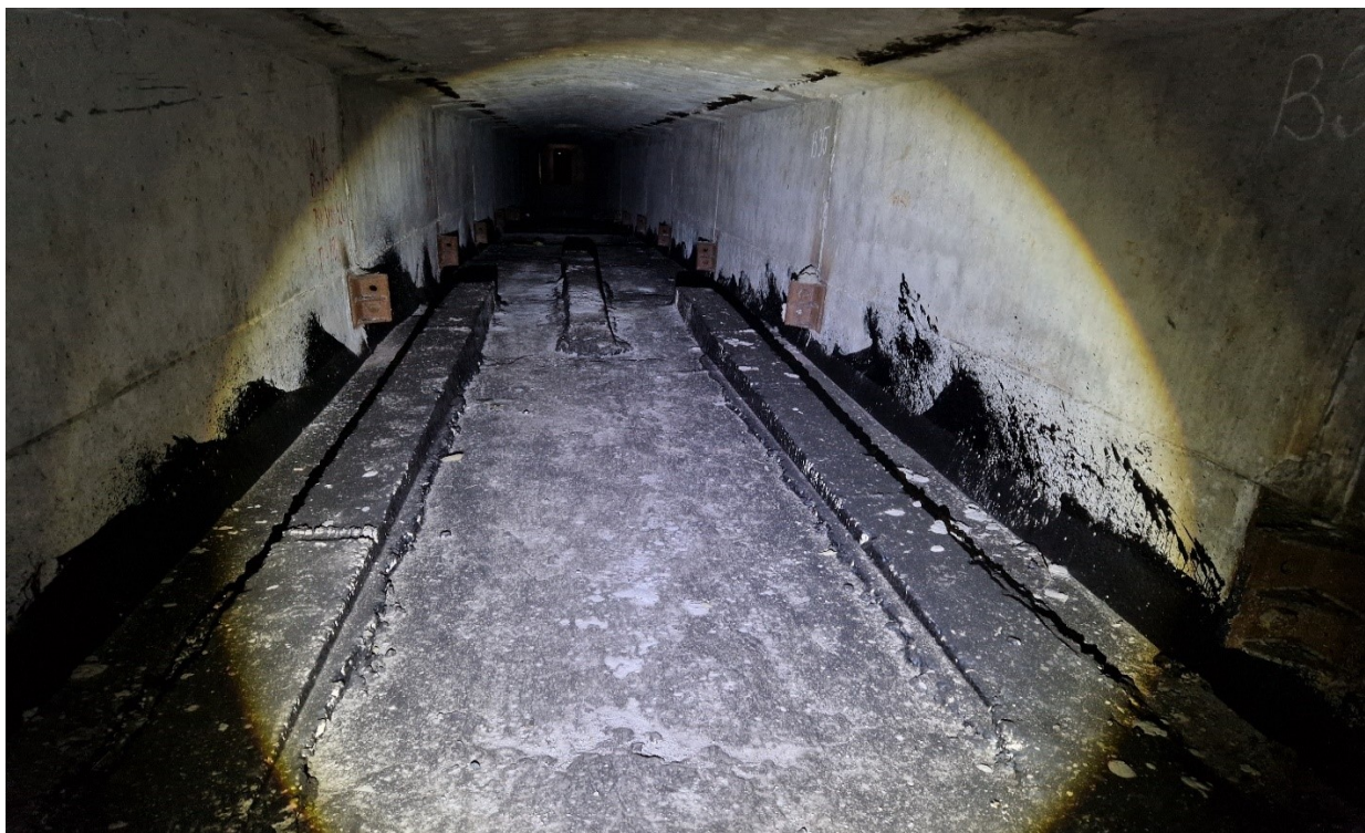
129 pav. Įtemptos armatūros išdėstymas „A“ sijos blokų viduje žiūrint nuo A33 bloko. Apžiūros metu defektų neužfiksuota
