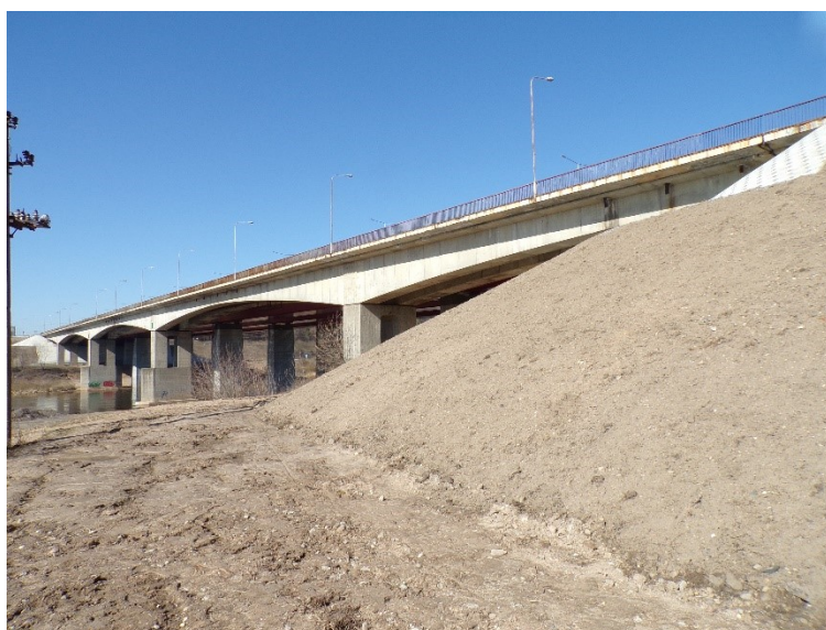
3 pav. Tiltu bendras vaizdas žiūrint nuo žemupio pusės
