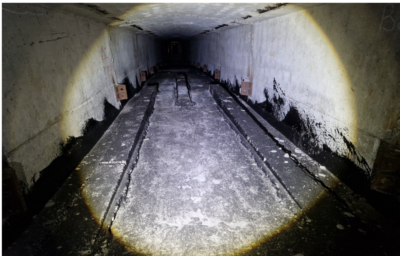
130 pav. Įtemptos armatūros išdėstymas „A“ sijos blokų viduje žiūrint nuo A34 bloko. Apžiūros metu defektų neužfiksuota
