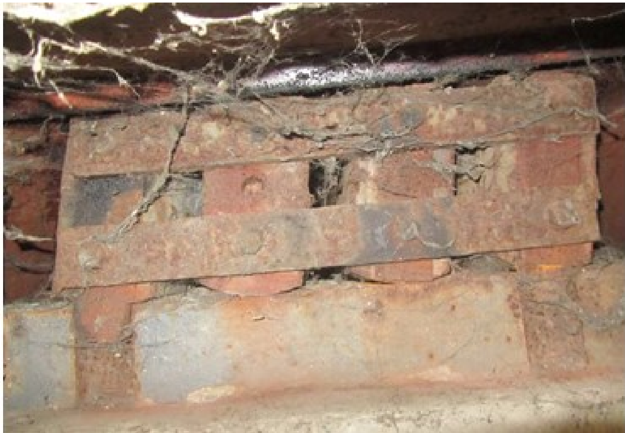
256 pav. Paslankus atraminis guolis virš 2 atramos po „A“ sija aukštupio pusėje. Guolio paritai faktiškai yra projektinėje padėtyje, tačiau visi metaliniai elementai yra stipriai pažeisti korozijos
