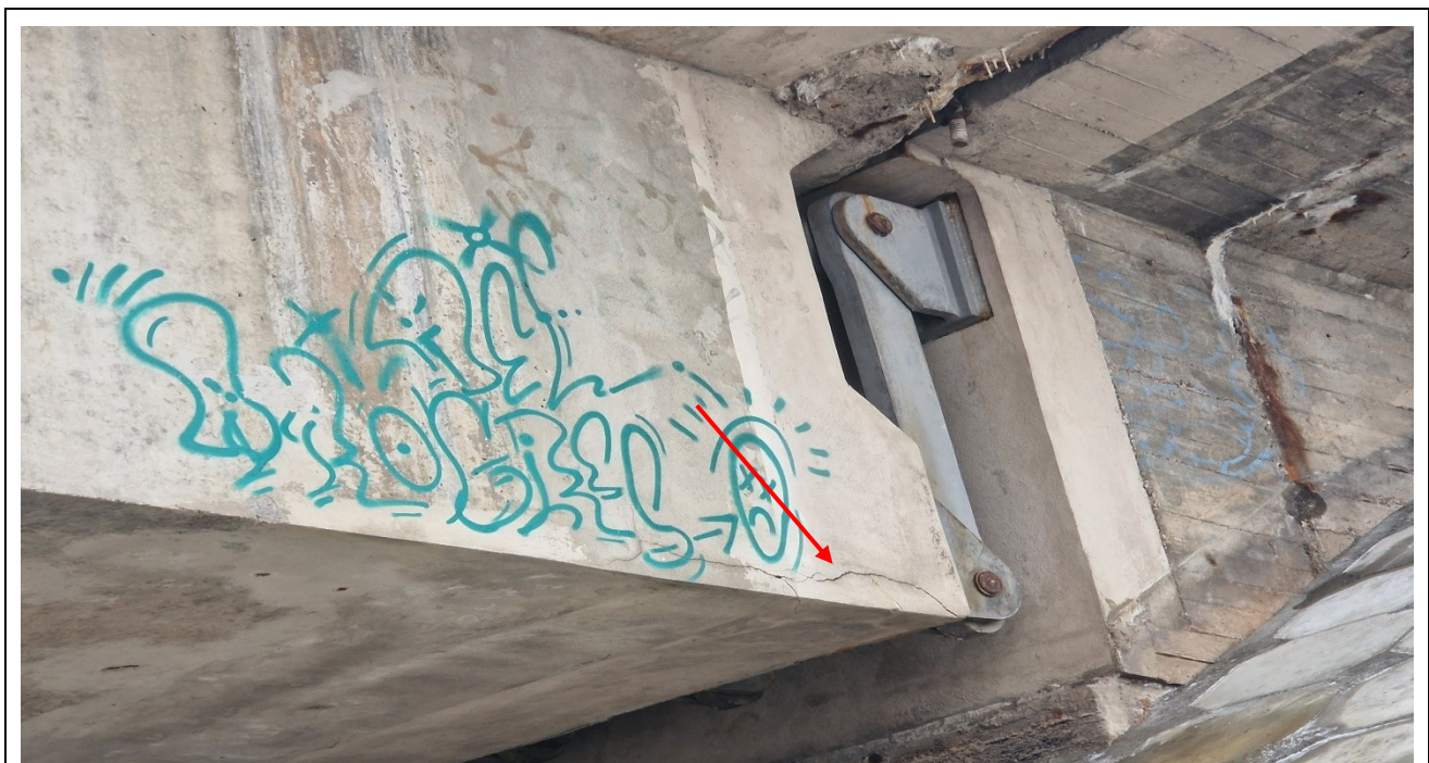
241 pav. „B“ sija žemupio pusė. Paslankus lankstas ties 1 atrama. Lanksto įtvirtinimo vietoje, ties bloko apačia, atsivėręs išilginis plyšys, lanksto metaliniai elementai pažeisti korozijos, lankstai neturi tepimo taškų
