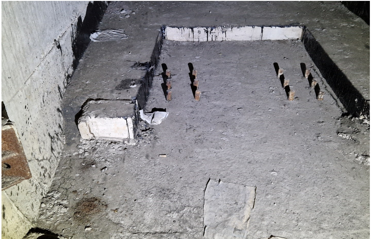
112 pav. Įtemptos armatūros inkarų fotofiksacija „A“ sijos aukštupio pusėje ties A25 bloku
