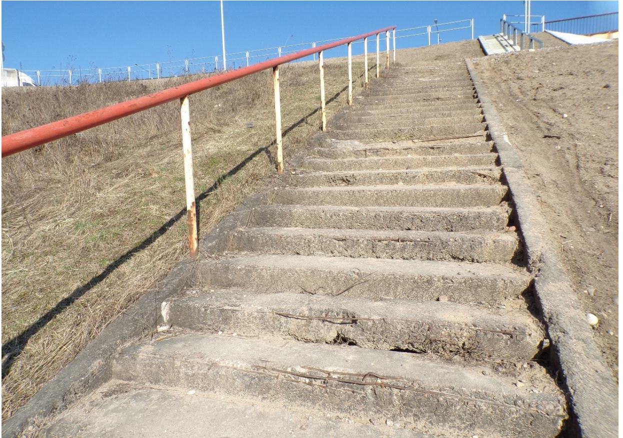
64 pav. Laiptai prietiltyje ties 6 atrama. Laiptų pakopos apirusios, vietomis iki armatūros, turėklai paveikti korozijos
