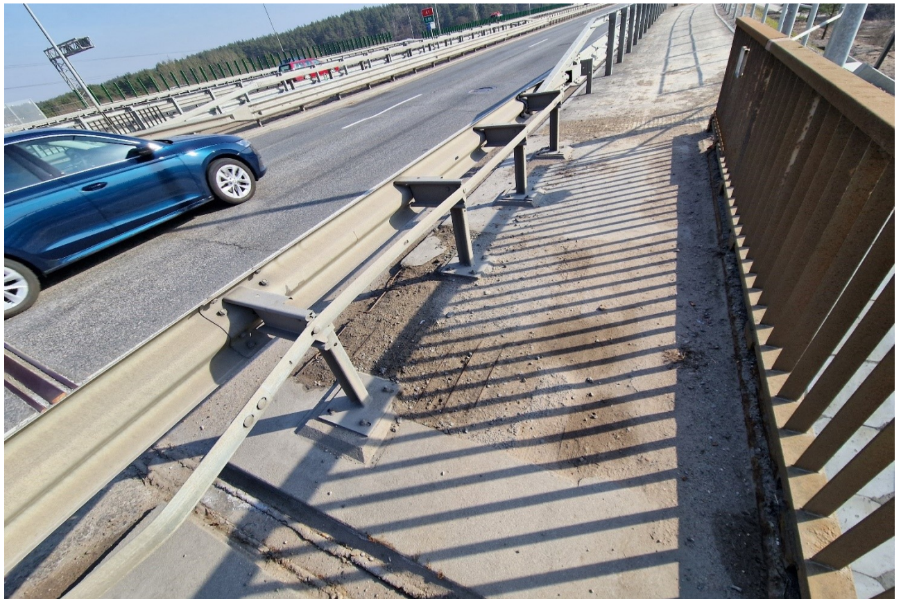
19 pav. Šaltilčio bendri vaizdai žemupio pusėje. Daugelyje vietų šaltilčių einamosios dalies paviršiai apirę ir užteršti purvu
