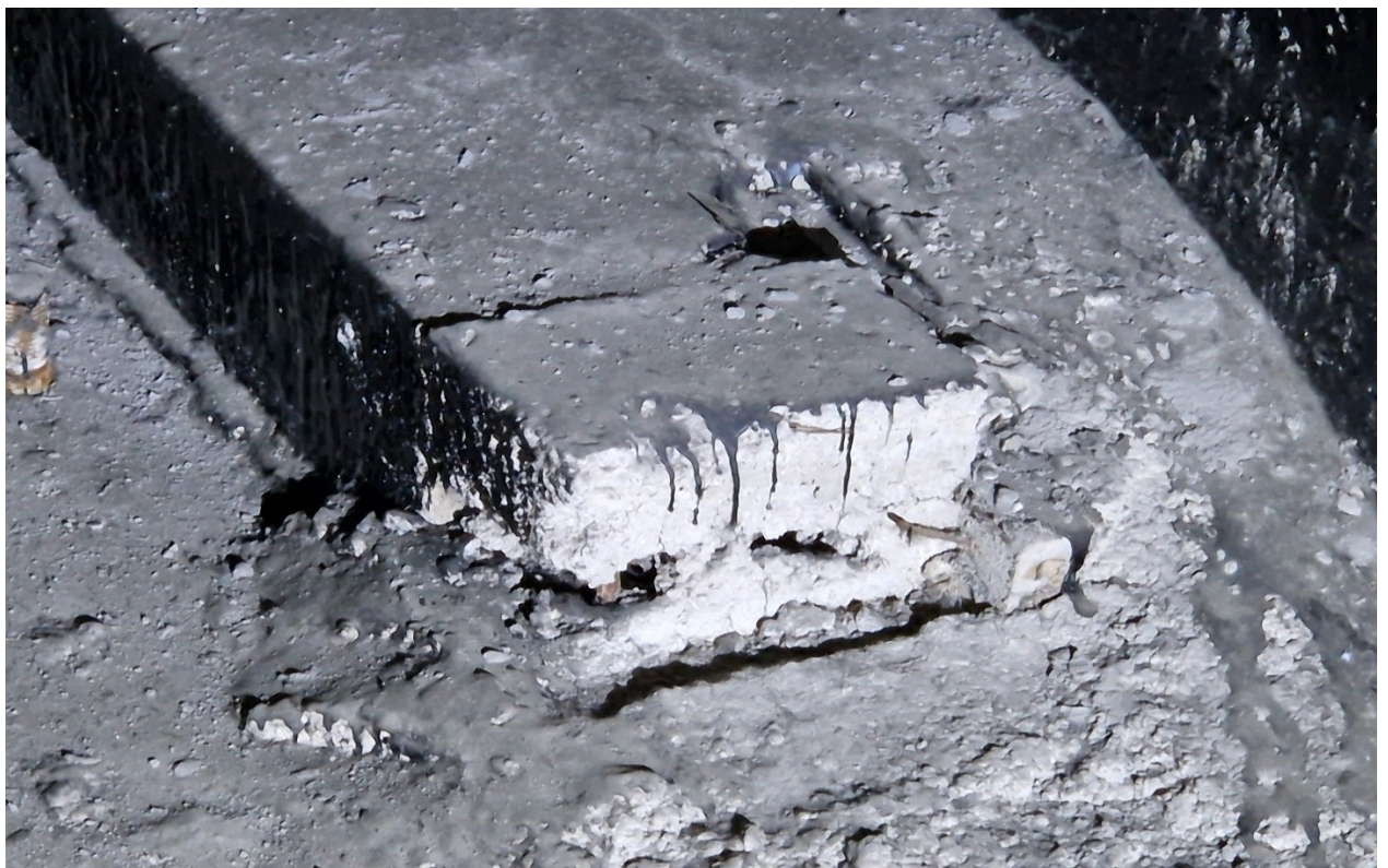
113 pav. Įtemptos armatūros inkarų fotofiksacija „A“ sijos žemupio pusėje ties A25 bloku. Inkaras ne iki galo yra užbetonuotas ir ne visas betonas yra padengtas bitumo mastika
