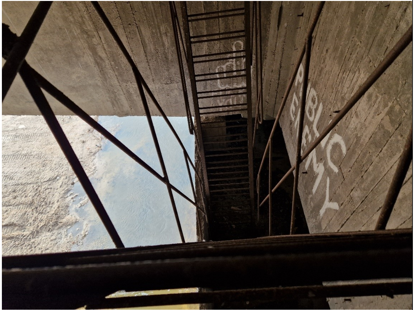
58 pav. Koroduoja metaliniai laiptai, skirti nulipimui virš trečios atramos apžiūrėti atraminiams guoliams
