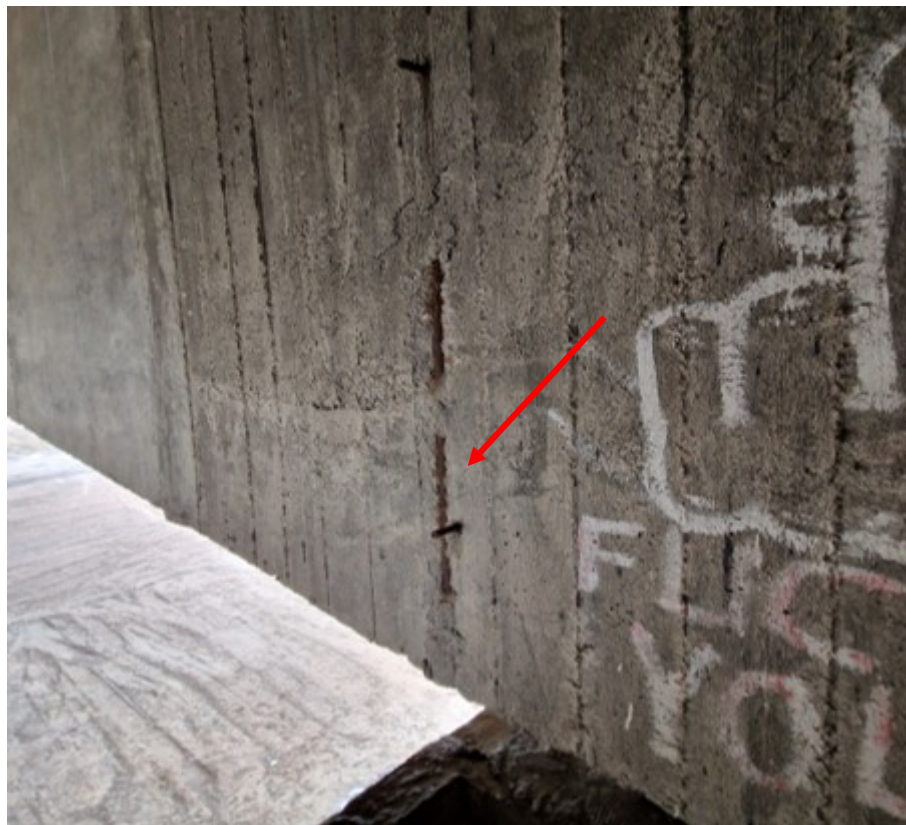
38 pav. „A“ sijos galas virš III atramos. Monolitiniame ruože lokaliai atsokęs ir nutrupėjęs apsauginis betono sluoksnis, koroduoja į paviršių išlindę armatūros strypai
