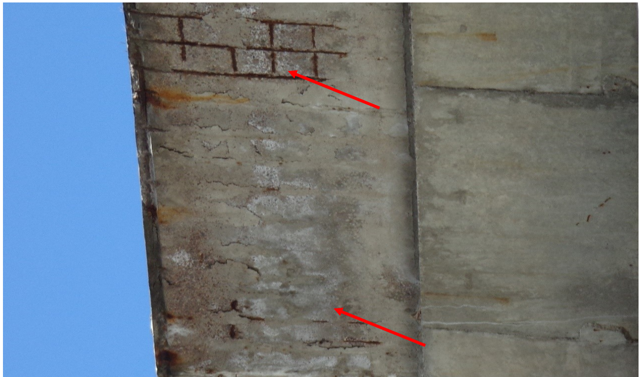
22 pav. Šaltilčių gembinėje dalyje per visą tilto ilgį koroduoja šaltilčių gėbių apatinė armatūra. Nuotraukoje A sijos žemupio pusės šaltilčio gembė ties 3 atrama
