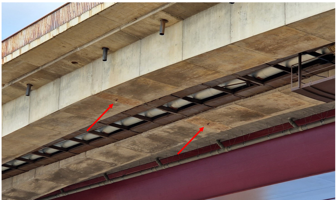
80 pav. Specialios prizmės įrengtos antrojo tarpatramio perdangos dėžinio skerspjūvio sijų apačioje deformacijų tyrimui
