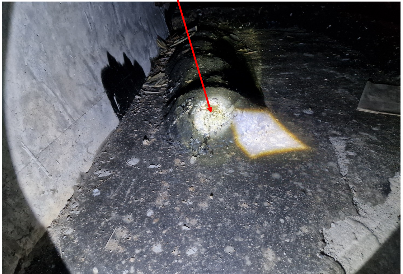
209 pav. Įtempta armatūra „B“ sijos bloko apačioje žiūrint nuo B56 bloko link III tarpatriamio perdangos vidurio. Gniūžtės gale papleišėjęs apsauginis betono sluoksnis, nežymiai koroduoja gniūžtės galas
