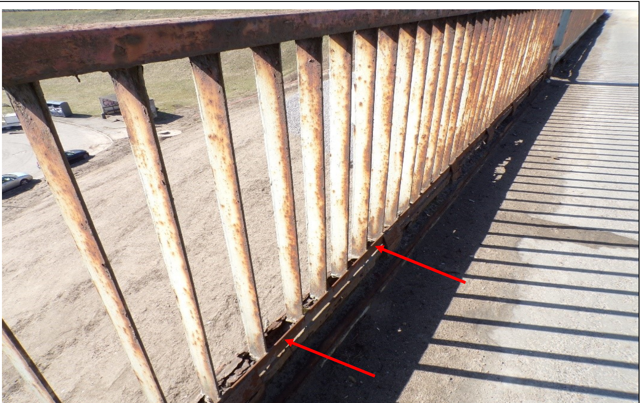
23 pav. Turėklai kairėje tilto pusėje (žemupyje) sukorodavę, turėklų įtvirtinimo vietose ir porankyje yra kiauryminės skylės. Dešinėje tilto pusėje turėklai visai išardyti, kad nekeltų pavojaus pėstiesiems ir eismo dalyviams po tiltu. Vietoj turėklų įrengta sieto tvorelė
