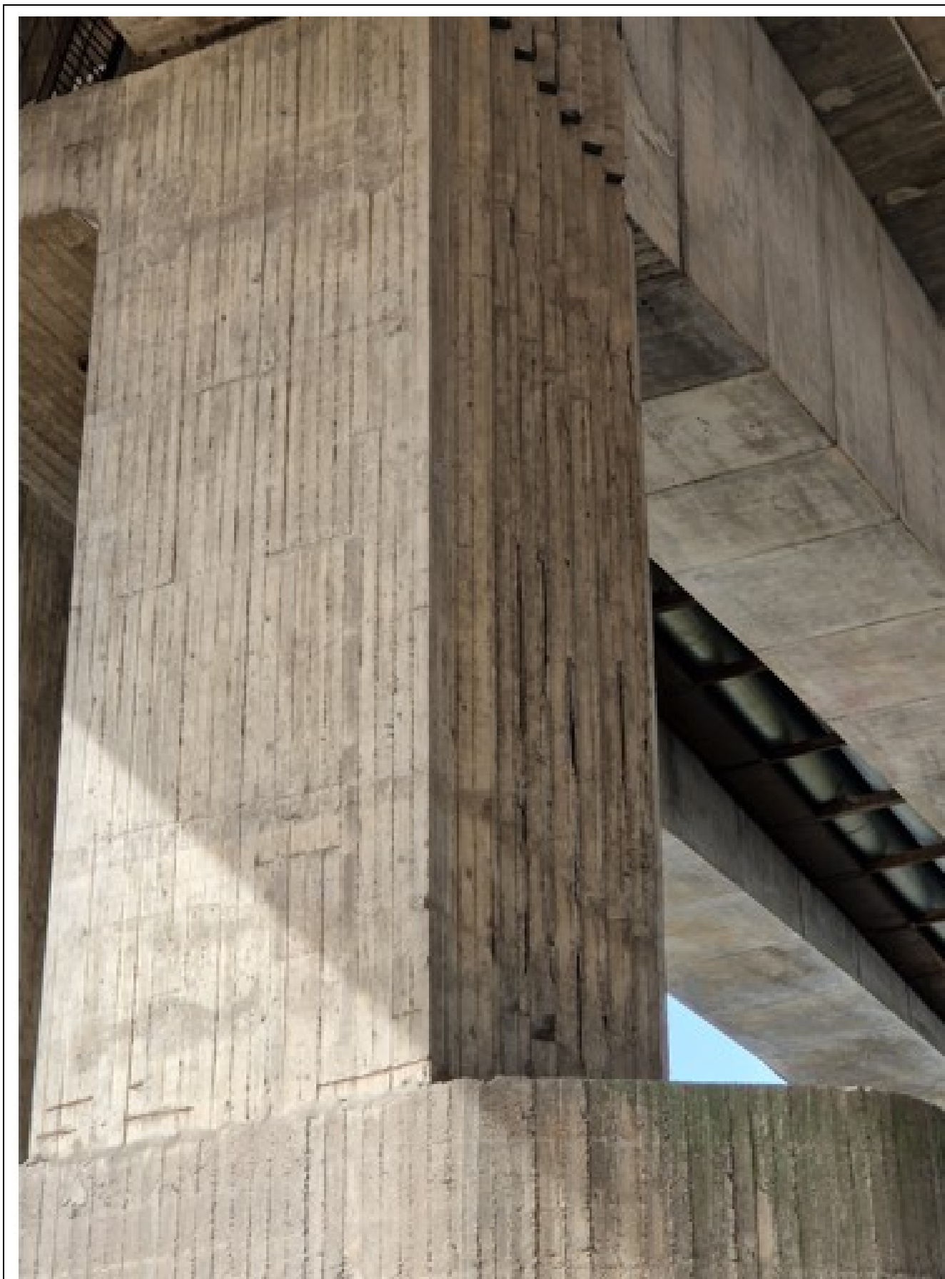
53 pav. Pradedą irti trečios atramos apdaila žemupio pusėje, pleišėja ir trupa apsauginis betono sluoksnis, koroduoja į paviršių išlindę išilginės armatūros strypai
