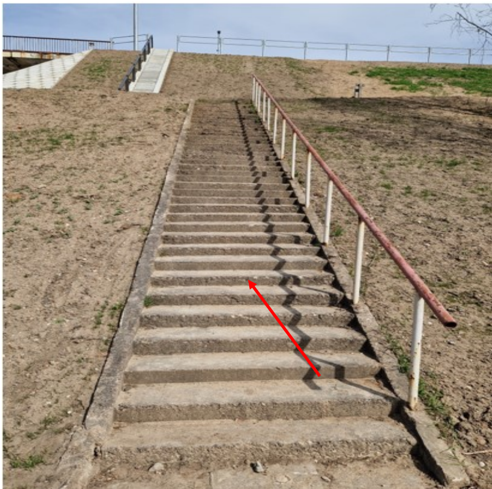
63 pav. Šlaitinių laiptų pakopos ties 1 atrama apirusios, koroduoja į paviršių išlindę armatūros strypai
