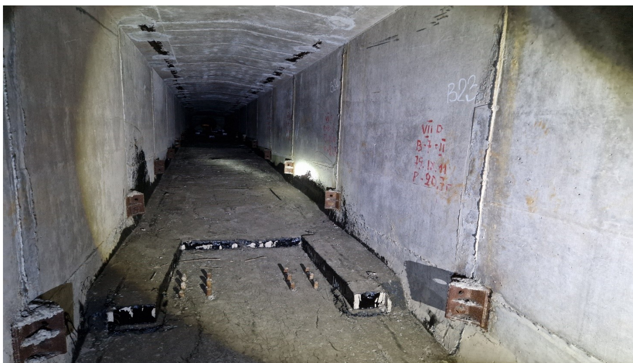
191 pav. Įtempta armatūra „B“ sijos bloko apačioje žiūrint nuo B23 bloko link ketvirto tarpatramio vidurio
