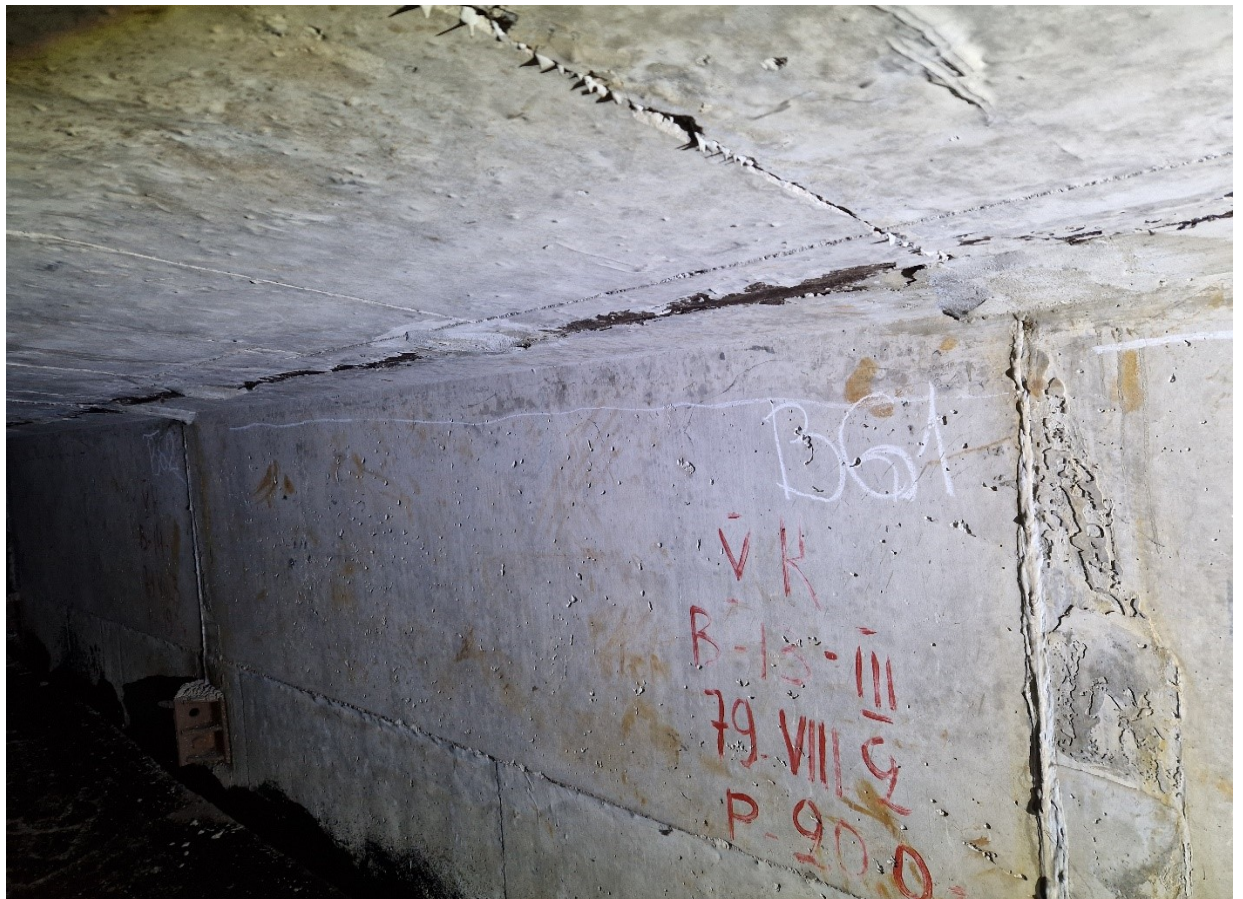
140 pav. „A“ sijos A61 bloko sienutės viršuje, žemupio pusėje, atsivėręs išilginis 0,15 mm pločio plyšys. Plyšys eina per visą bloko plotį
