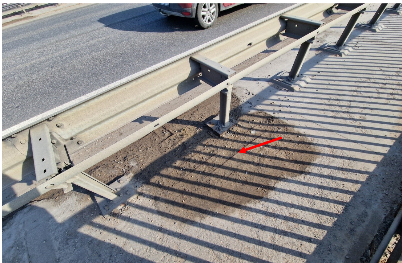
18 pav. Šaltilčio bendri vaizdai žemupio pusėje. Šaltilčių blokai nuo važiujamosios dalies pusės suirę iki pat atitvarų įtvirtinimo vietos. Daugelyje vietų šaltilčių einamosios dalies paviršiai apirę ir užteršti purvu
