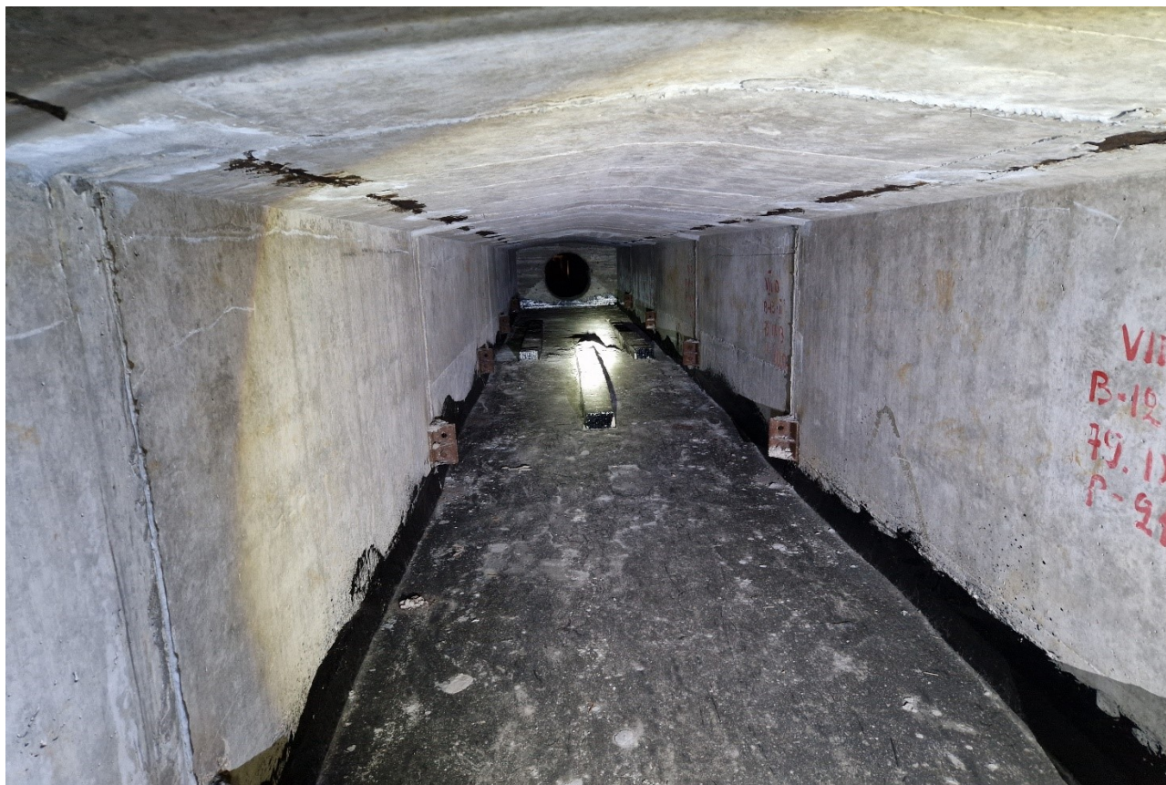
192 pav. Įtempta armatūra „B“ sijos bloko apačioje žiūrint nuo B28 bloko link ketvirto tarpatramio vidurio. Armatūra užbetonuota, betonas padengtas apsaugine bitumo danga. Apžiūros metu defektų neužfiksuota
