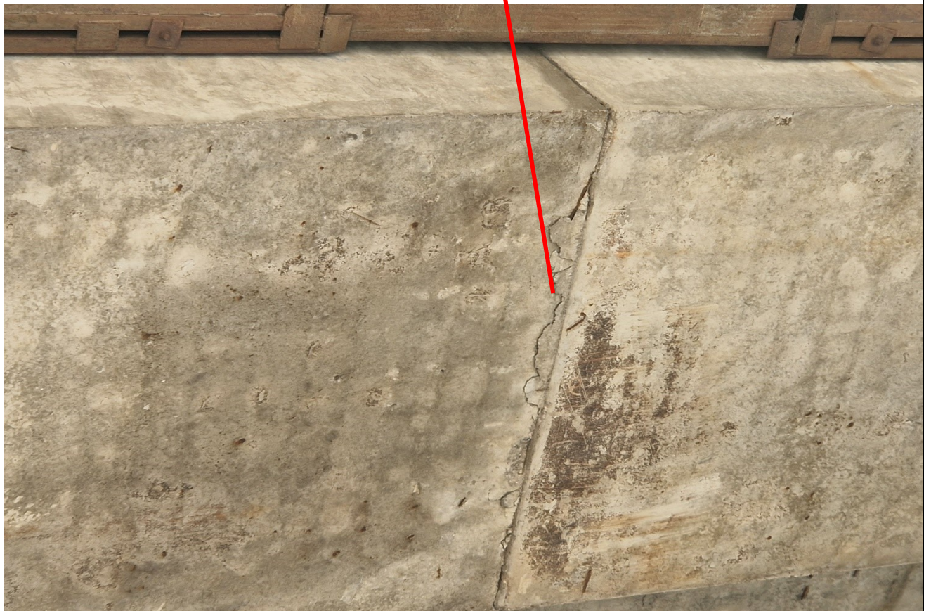
43 pav. Lokalioje vietoje „B“ sijos 5 bloke (skaičiuojant nuo 1 atramos) ties sandūra papleišėjęs ir atšokęs apsauginis betono sluoksnis
