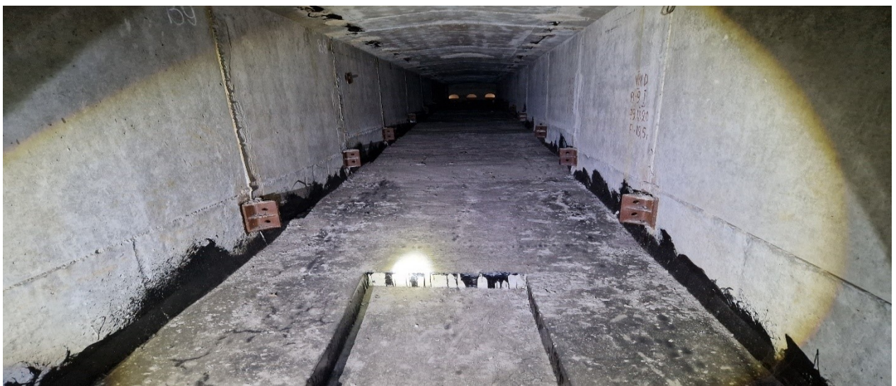
189 pav. Įtempta armatūra „B“ sijos blokų apačioje žiūrint nuo B9 bloko link 6 atramos. Armatūra užbetonuota, ir betono paviršius padengtas bitumo mastika. Galai, ties inkarais, nėra padengti bitumo danga
