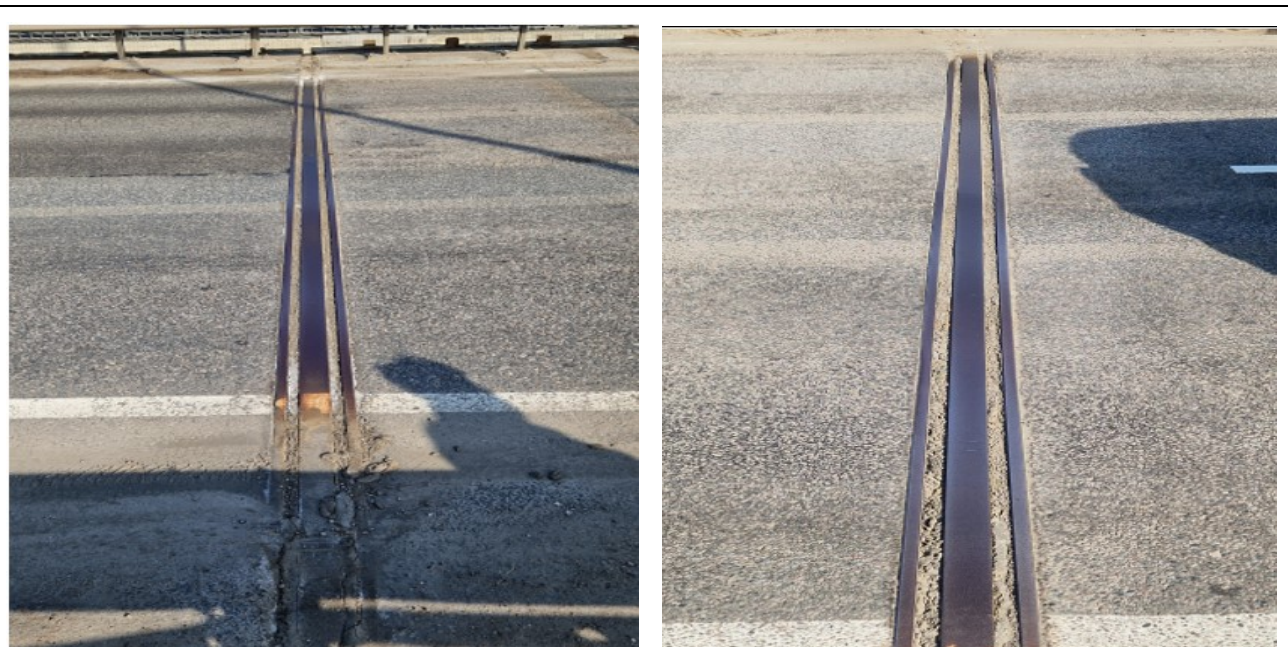
14 pav. Deformacinių pjūvių bendri vaizdai, kairėje pusėje – deformacinis pjūvis virš 1 atramos, dešinėje pusėje – deformacinis pjūvis virš 6 atramos. Abu pjūviai važiuojamojoje dalyje yra sandarūs, tačiau tarpai užnešti žemių ir žvyro mišiniu, suvaržytos tilto temperatūrinės deformacijos
