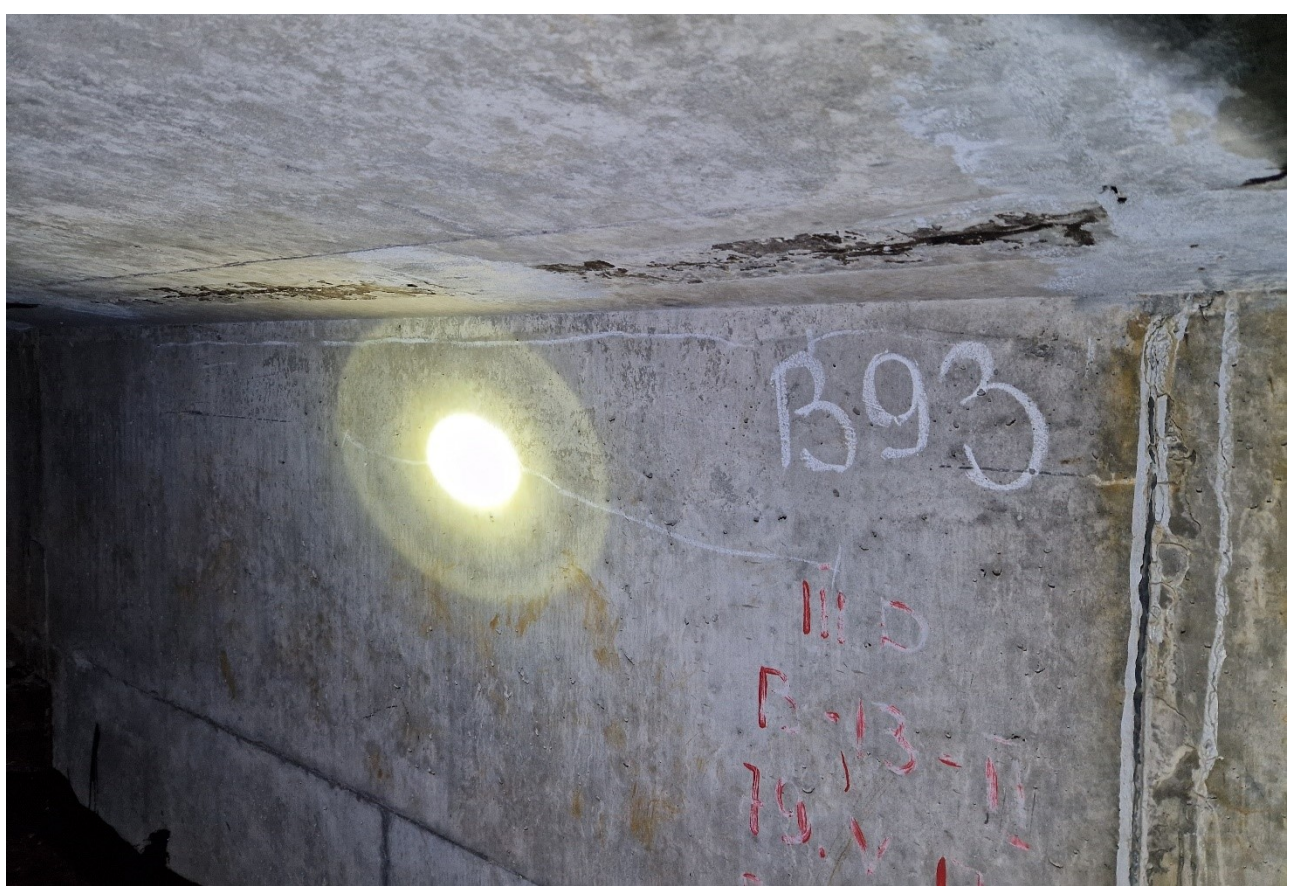
226 pav. „B“ sijos B93 bloko sienutėje, žemupio pusėje atsivėrę išilginiai 0,1 mm pločio plyšiai
