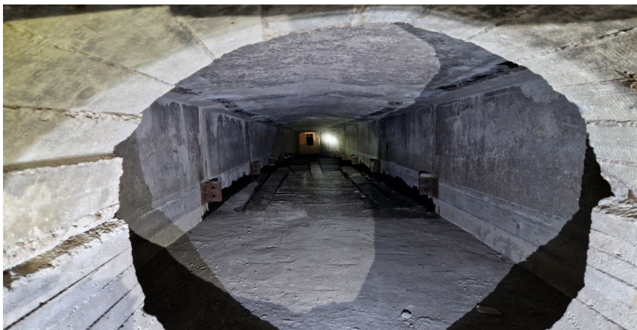
236 pav. Įtempta armatūra „B“ sijos apačioje žiūrint nuo II tarpatriamio perdangos vidurio link II atramos. Armatūra užbetonuota ir betonas padengtas apsaugine bitumo danga. Apžiūros metu defektų neužfiksuota
