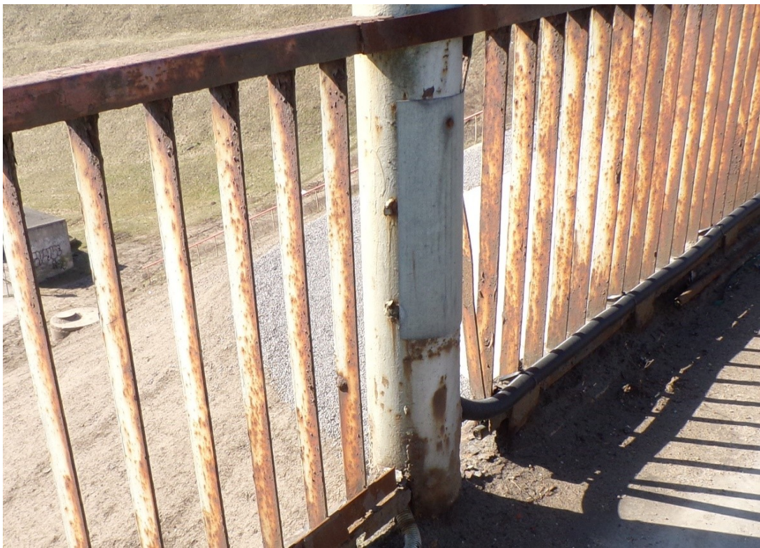
65 pav. Per visą tilto ilgį surūdiję šviestuvų stulpai
