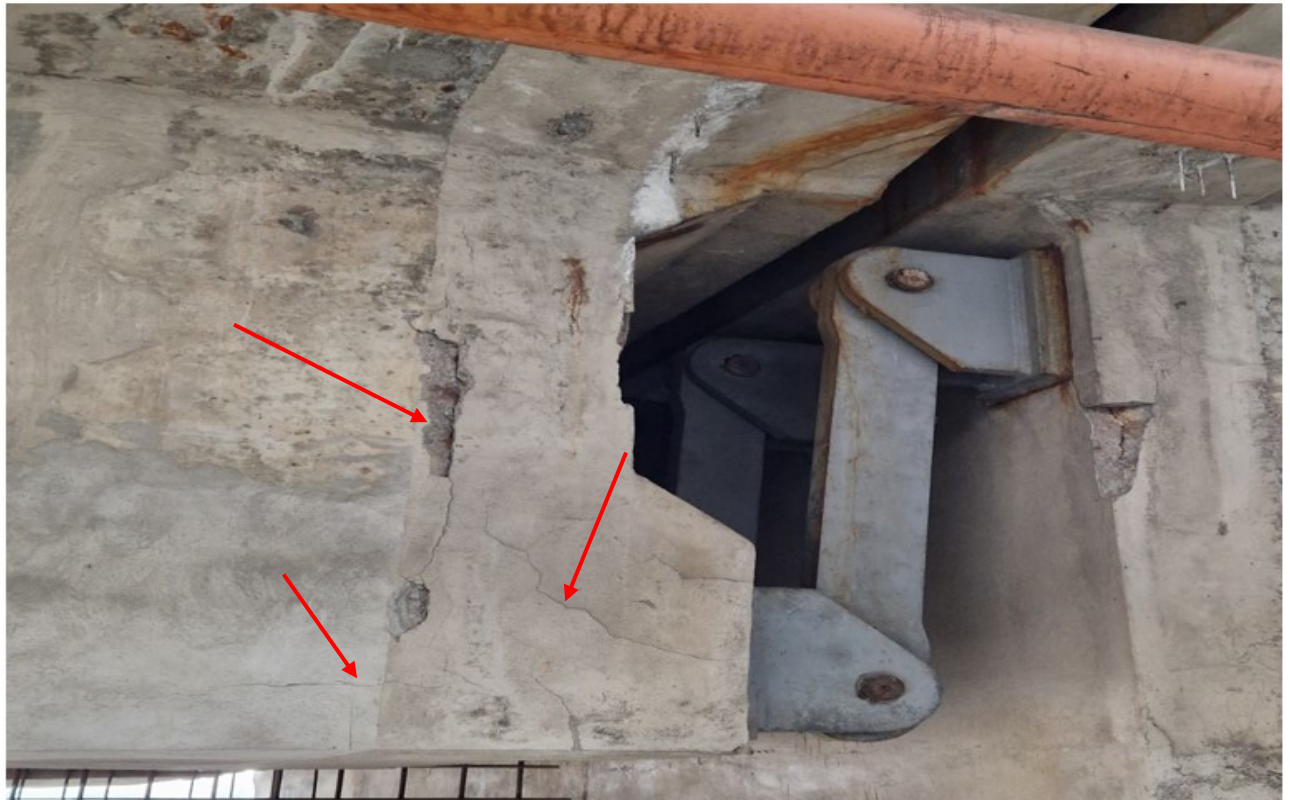
244 pav. „A“ sija aukštupio pusė. Paslankus lankstas ties 6 atrama. Lanksto apačioje supleišėjęs sijos bloko betonas, koroduoja lankstų metaliniai elementai, lankstai neturi tepimo taškų
