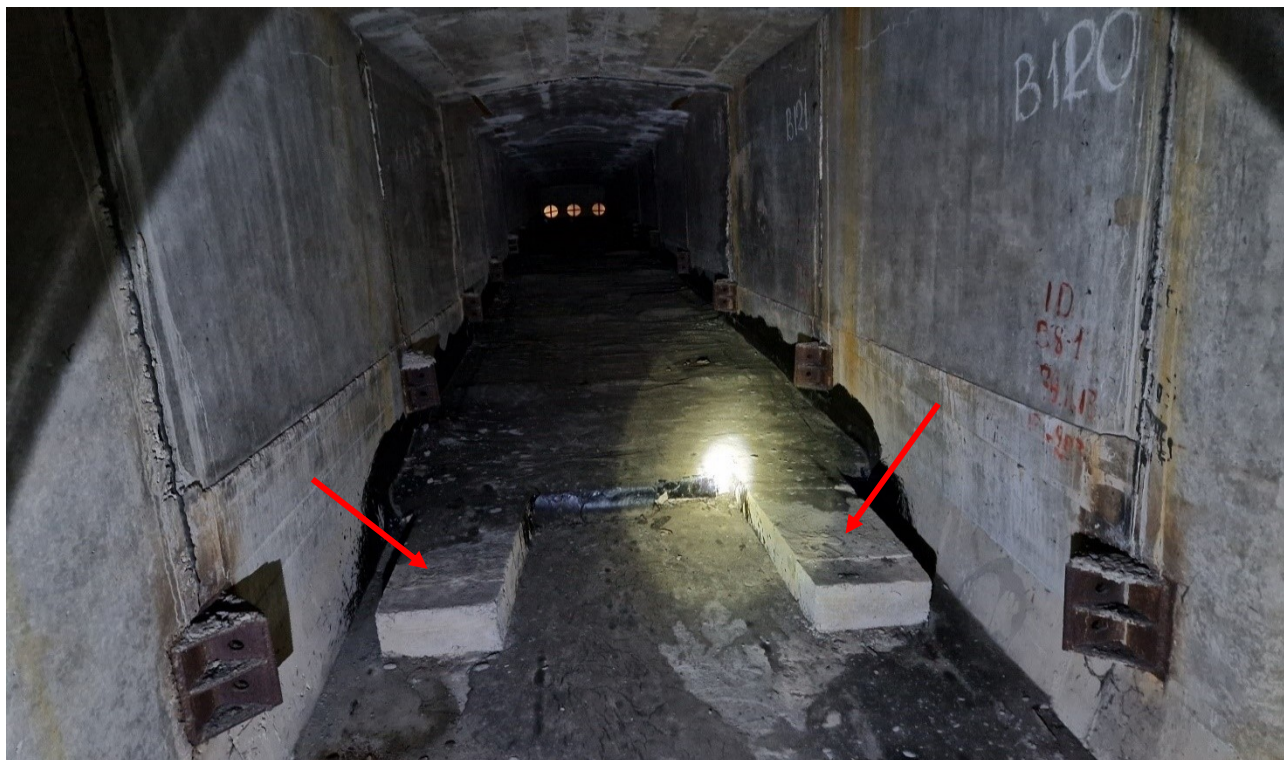
239 pav. „B“ sijos B120 ir B121 blokų sienutėse, žemupio pusėje, matyti vandens tekėjimo žymės, įtemptos armatūros gniūžtės yra užbetonuotos, tačiau galuose betonas nėra padengtas apsaugine bitumo danga
