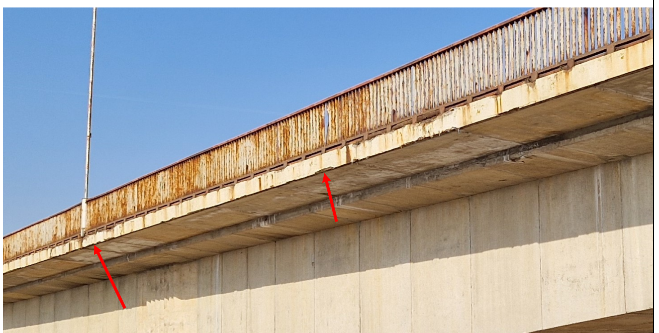
26 pav. Turėkliinių blokų bendras vaizdas žemupio pusėje. Daugelyje vietų apirusios turėkliinių blokų apačios, lokaliuose vietose stipriai ištrupėjęs betonas
