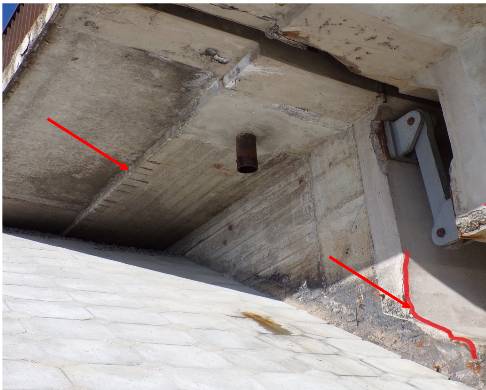
47 pav. Šešto ramto sparno gembėje koroduoja armatūra, supleišėjęs atkaltės ir sparno sandūros kampas. Nuotraukoje ramto vaizdas ties „A“ sija žemupio pusėje
