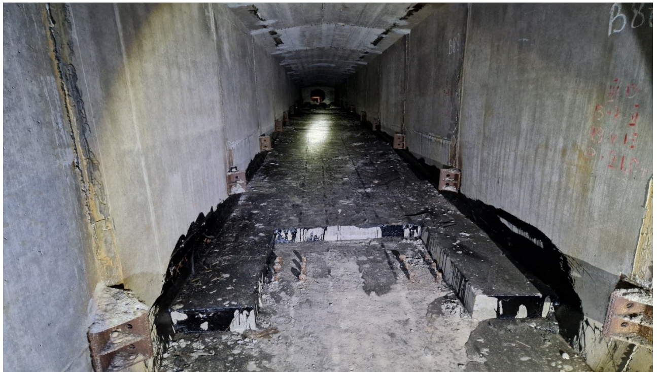
224 pav. Įtempta armatūra „B“ sijos apačioje žiūrint nuo B88 bloko link II tarpatramio perdangos vidurio. Įtempta armatūra užbetonuota, betonas padengtas apsaugine bitumo danga, apžiūros metu defektų neužfiksuota
