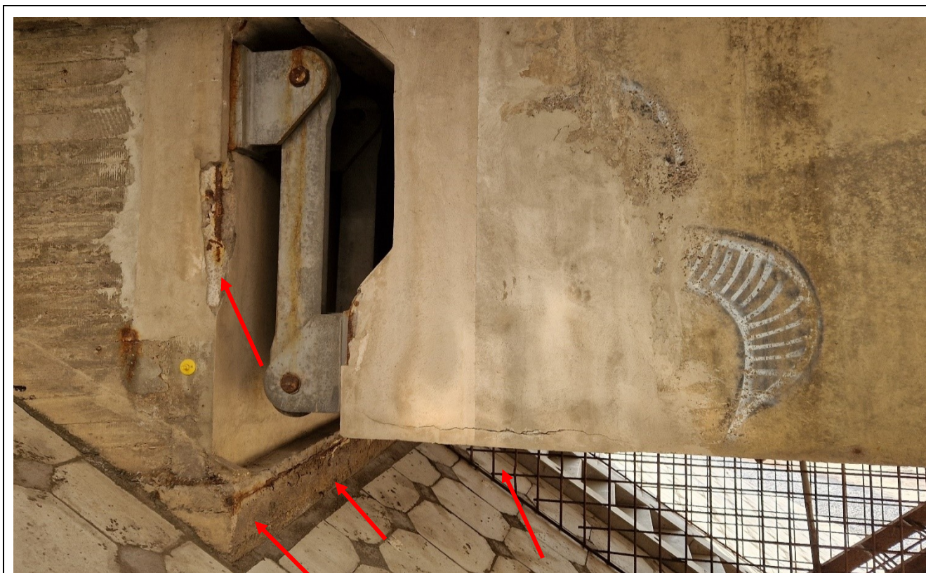
29 pav. Supleišėjęs dėžinio bloko kampas ir atkaltės kampas. Vaizdas „B“ sijoje, aukštupio pusėje, ties 1 atrama. Lokaliuose vietose atsokęs ir nukritęs apsauginis betono sluoksnis, koroduoja į paviršių išlindę armatūros strypai
