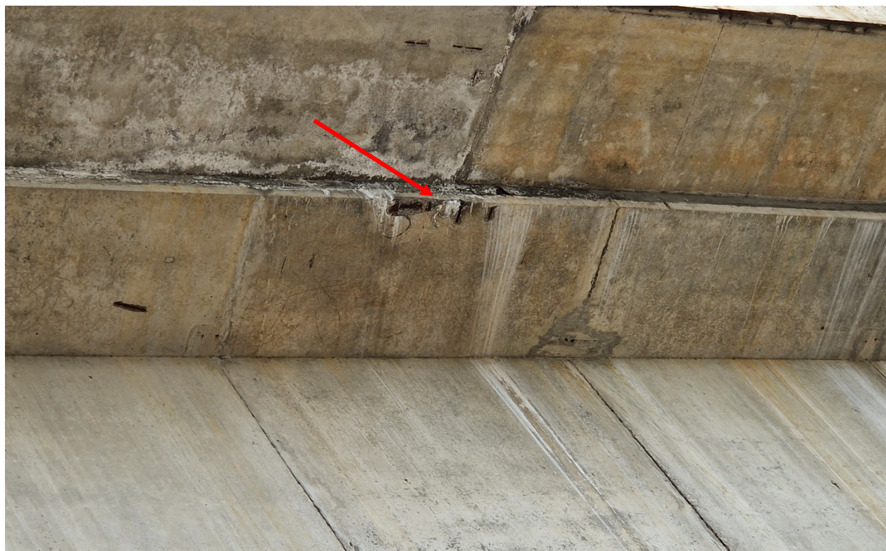
42 pav. Lokaliuose vietose papleišėjusios „A“ sijos blokų lentynos aukštupio pusėje, vietomis atšokęs apsauginis betono sluoksnis, koroduoja į paviršių išlindę pagrindinės ir pagalbinės armatūrų strypai
