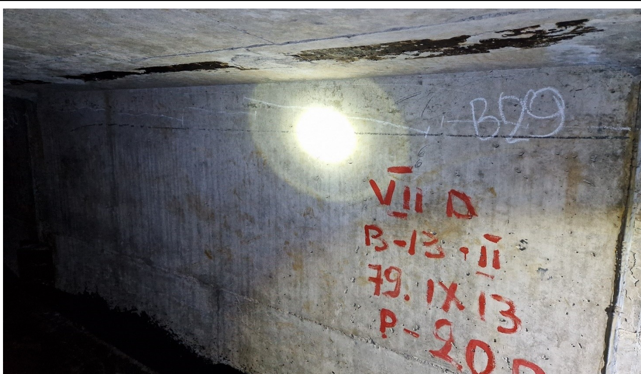
193 pav. Įstrižais plyšiais papleišėjusi „B“ sijos B29 bloko sienutė žemupio pusėje
