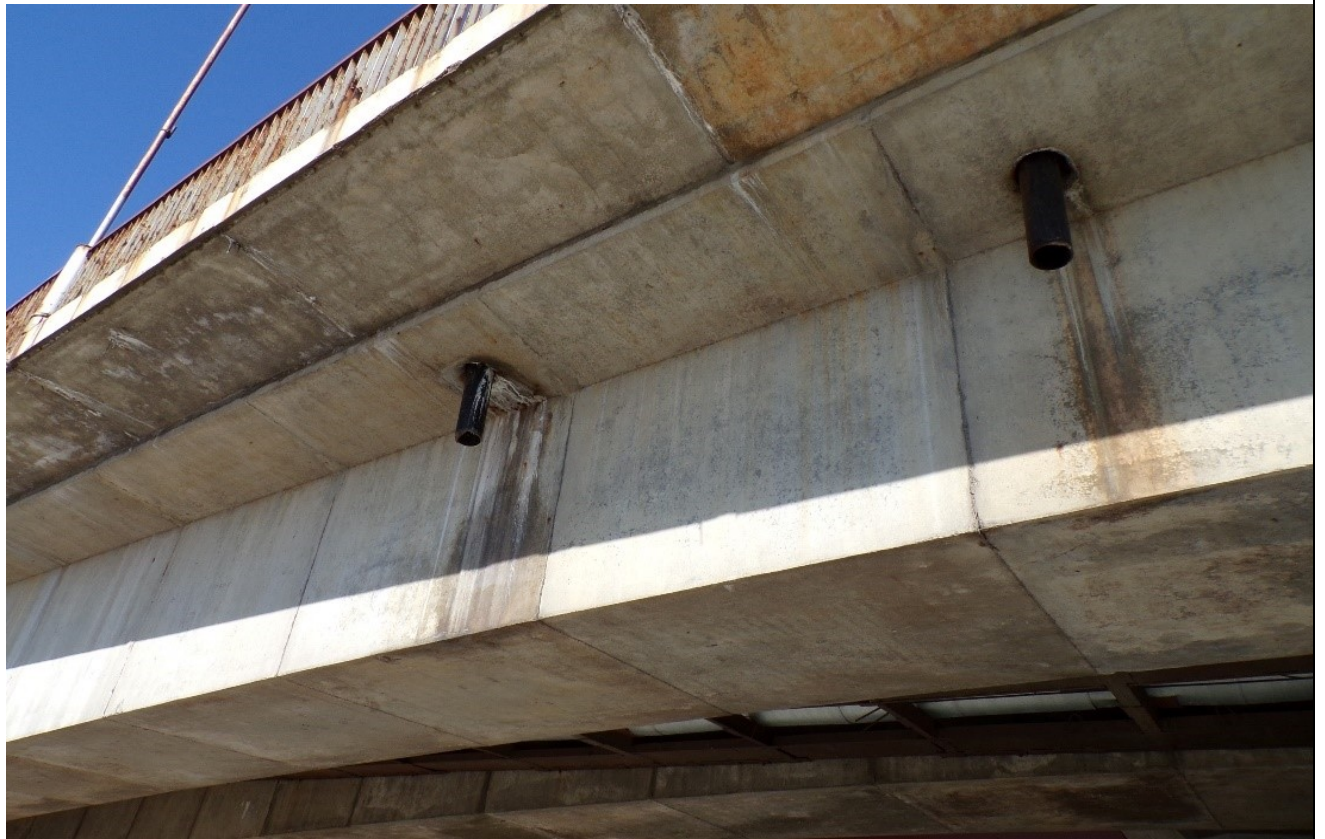
27 pav. Šulinėliai per trumpi, ties šulinėliais nesandari hidroizoliacija. Iš šulinėlių ištekantis vanduo ir druskų tirpalai drėkina blokų paviršius
