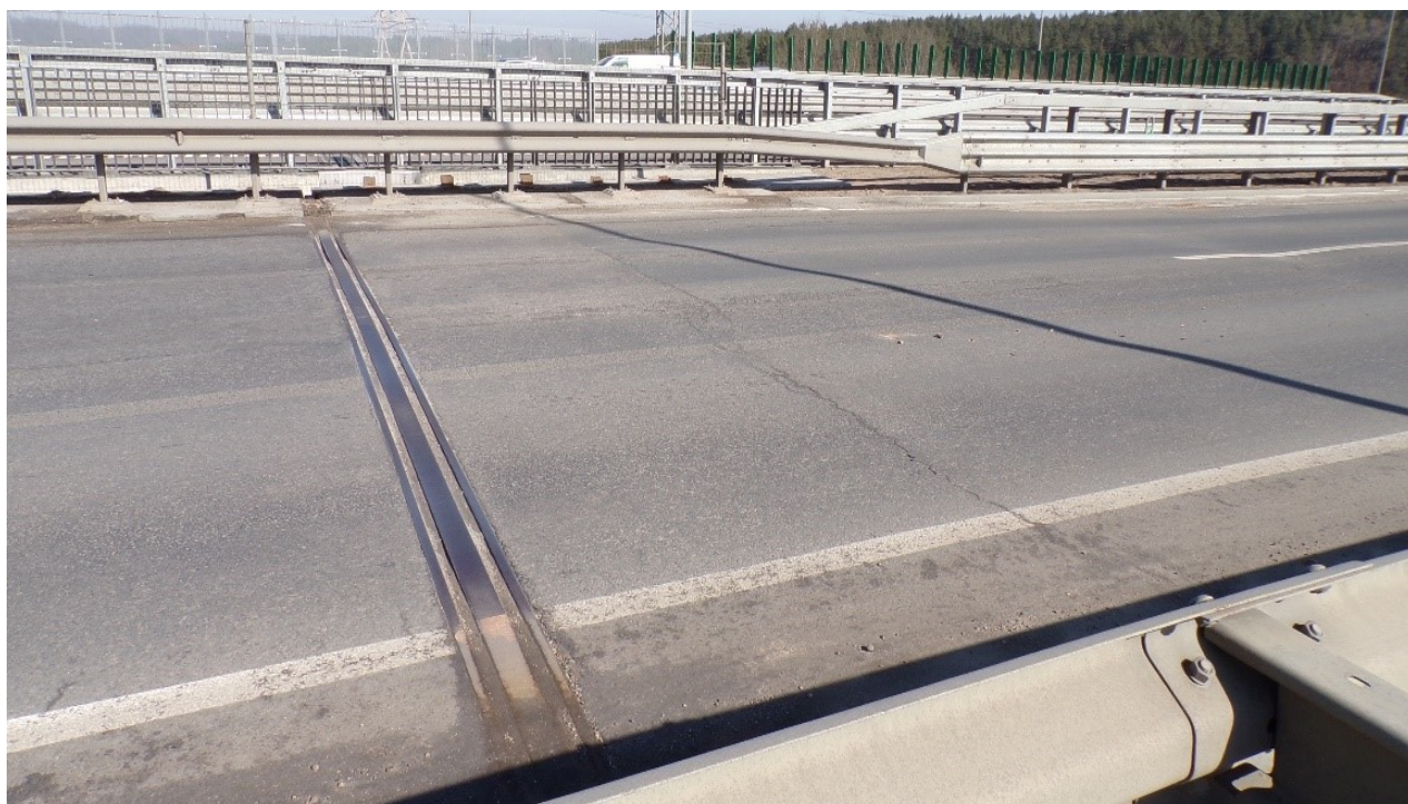
60 pav. Prietiltis ties 1 atrama. Asfalto danga supleišėjusi ir provėžuota, deformacinis pjūvis antroje eismo juostoje įdubęs
