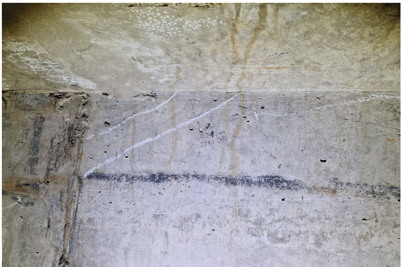
115 pav. „A“ sijos A26 bloko sienutėje palei viršų atsivėręs 0,10 mm pločio įstrižas plyšys
