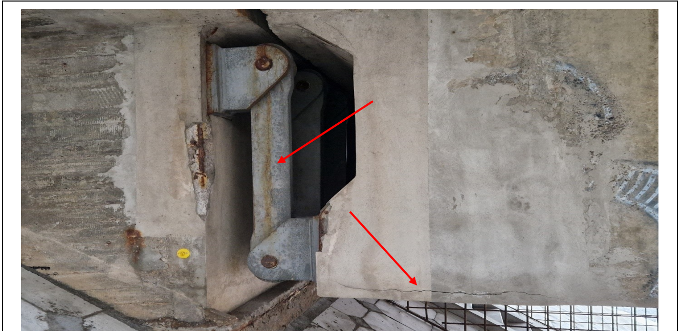
240 pav. „A“ sija aukštupio pusė. Paslankus lankstas ties 1 atrama. Lanksto įtvirtinimo vietoje, ties bloko apačia, atsivėręs išilginis plyšys. Lanksto metaliniai elementai pažeisti korozijos
