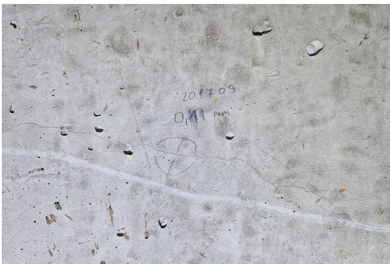
117 pav. „A“ sijos A28 bloko sienutėje palei viršų atsivėręs 0,10 mm pločio įstrižas plyšys
