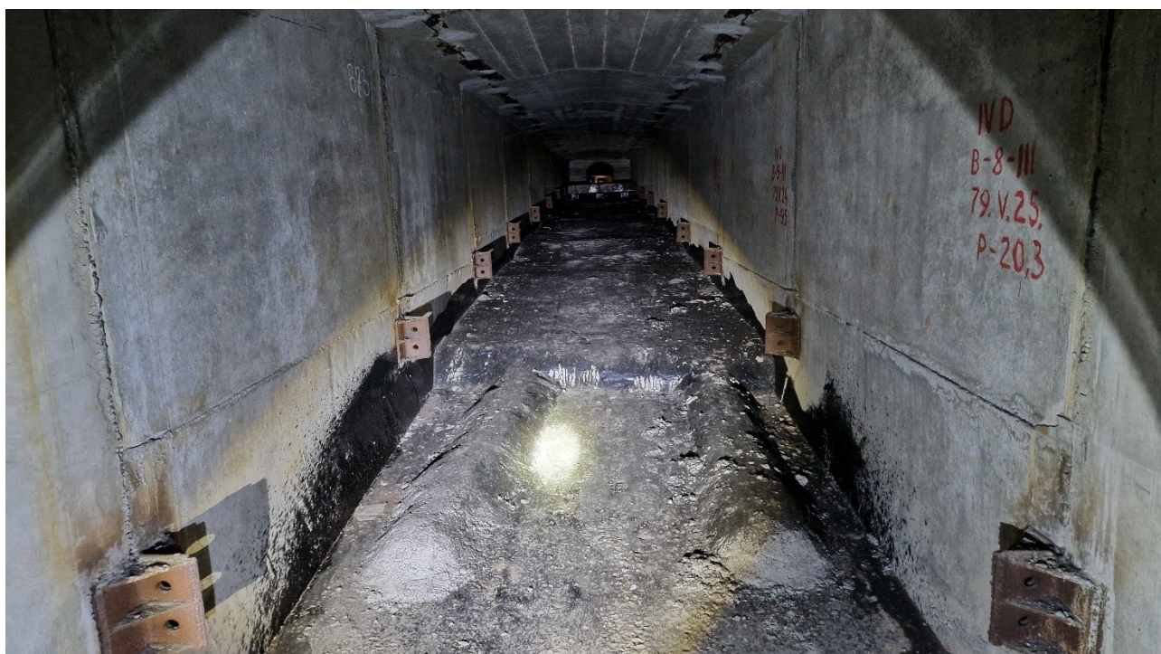
222 pav. Įtempta armatūra „B“ sijos apačioje žiūrint nuo B73 bloko link III tarpatramio perdangos vidurio. Įtemptos armatūros apsauginio betono būklė gera, defektų apžiūros metu neužfiksuota. B72, B73 ir B74 blokų sienutėse matyti vandens tekėjimo žymės
