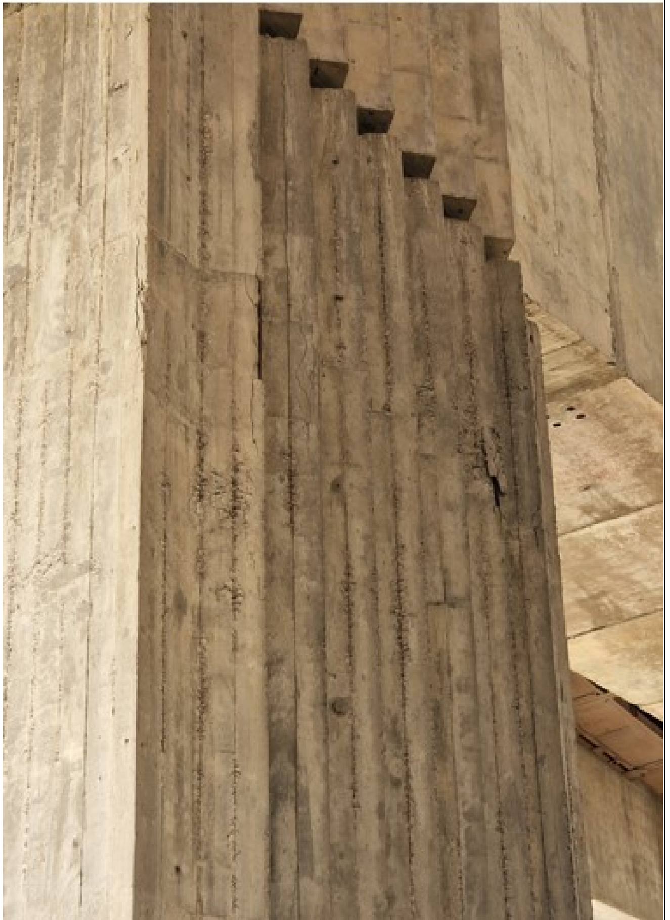
51 pav. Antros atramos apdaila nuo žemupio pusės pradėjusi irti, pleišėja ir trupa apsauginis betono sluoksnis, koroduoja į paviršių išlindę armatūros strypai
