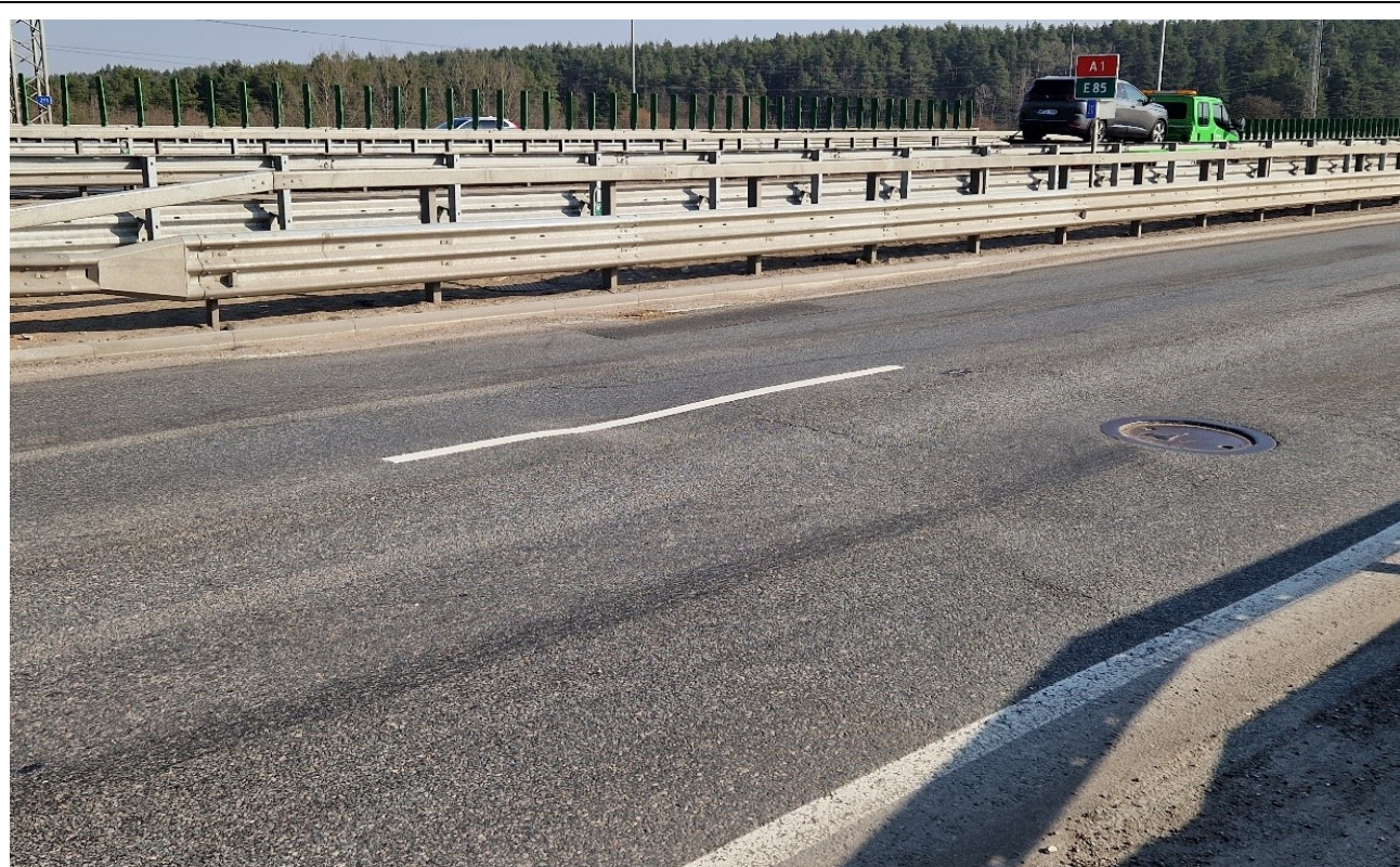
61 pav. Prietiltis ties 1 atrama. Asfalto danga provėžuota, supleišėjusi ir įdubusi ties pereinamųjų plokščių galais
