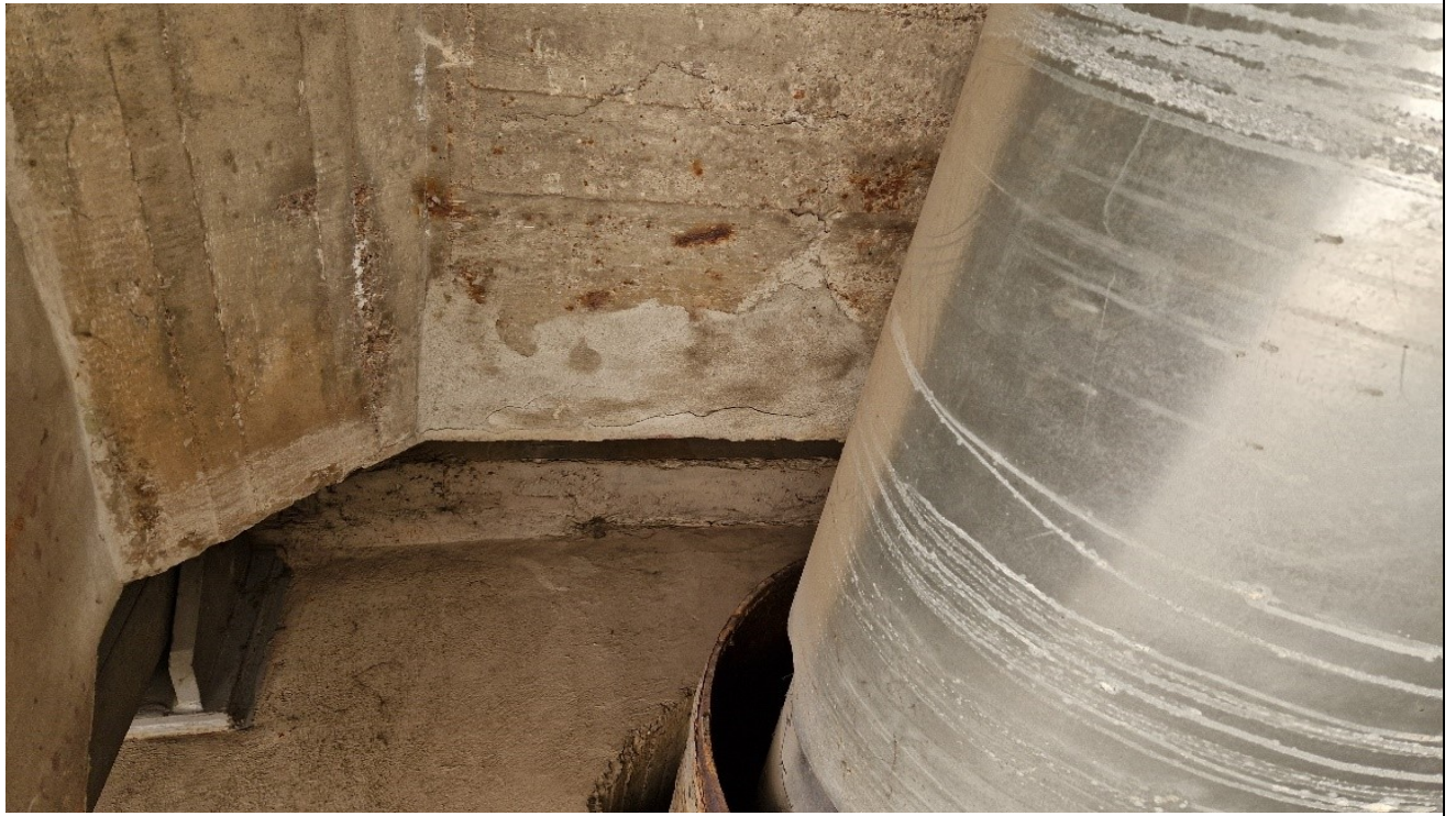
39 pav. Skersinė diafragma tarp perdangos sijų virš 1 atramos. Diafragmos apačioje papleišėjęs apsauginis betono sluoksnis, lokaliuose vietose išlindę koroduojantys pagalbinės armatūros strypai
