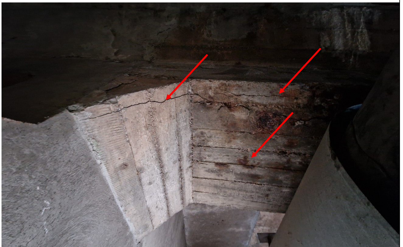
40 pav. Skersinė diafragma tarp perdangos sijų virš 6 atramos. Diafragmos apačioje papleišėjęs apsauginis betono sluoksnis, lokaliuose vietose išlindę koroduojantys pagalbinės armatūros strypai
