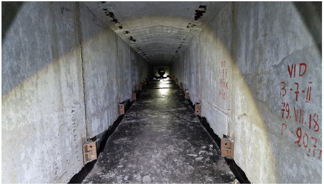
207 pav. Įtempta armatūra „B“ sijos apačioje žiūrint nuo B42 bloko link III tarpatramio perdangos vidurio
