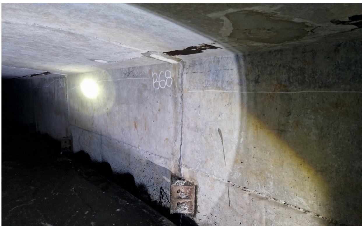
153 pav. „A“ sijos A68 bloko sienutės viršuje, žemupio pusėje, atsivėręs išilginis 0,15 mm pločio plyšys. Plyšys eina per visą bloko plotį
