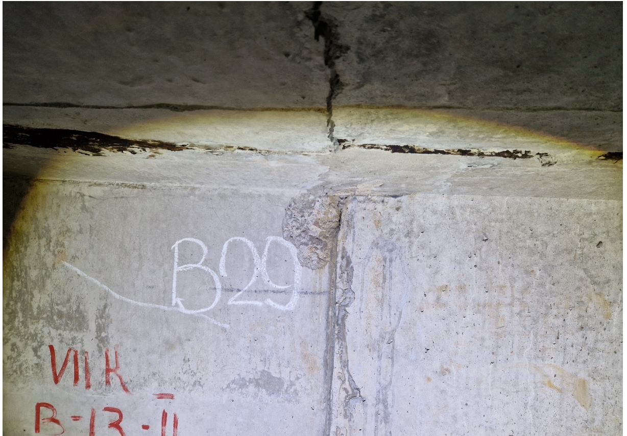
118 pav. Lokali pažaida „A“ sijos A29 bloko viršuje. Atšokęs ir nukritęs apsauginis betono sluoksnis
