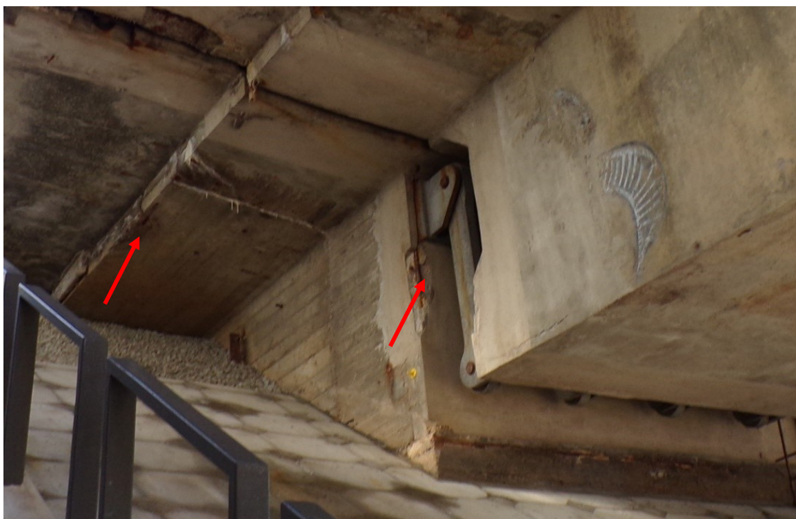
46 pav. Pirmo ramto paviršiuose yra armatūros korozijos požymių. Nuotraukoje ramto vaizdas ties „B“ sija: dėl korozijos nuskilęs atkaltės kampas, apirusi sparno gembinė dalis
