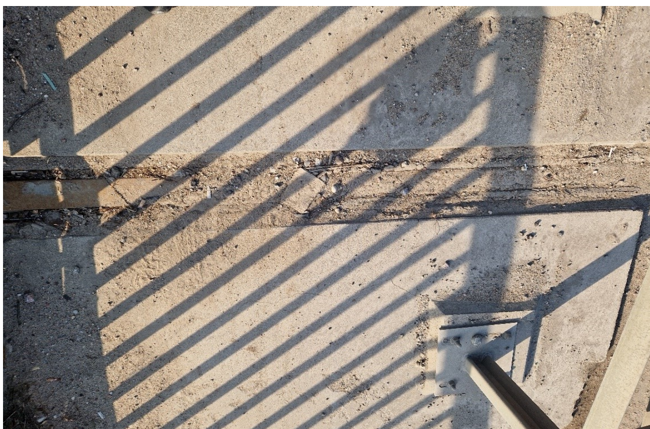
16 pav. Kiauras šaltilčio deformacinis pjūvis virš 6 atramos žemupio pusėje. Pjūvio tarpas pilnas žemių ir šiukšlių
