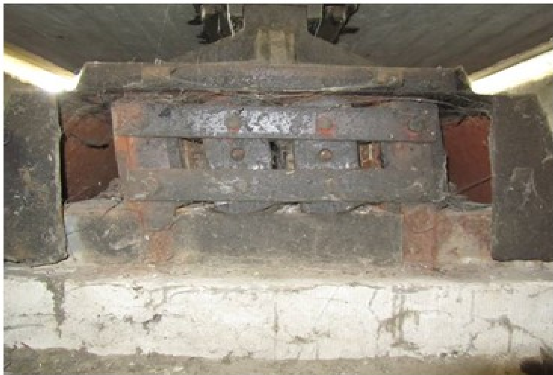
257 pav. Paslankus atraminis guolis virš 2 atramos po „B“ sija žemupio pusėje. Guolio paritai faktiškai yra projektinėje padėtyje, tačiau visi metaliniai elementai stipriai pažeisti korozijos
