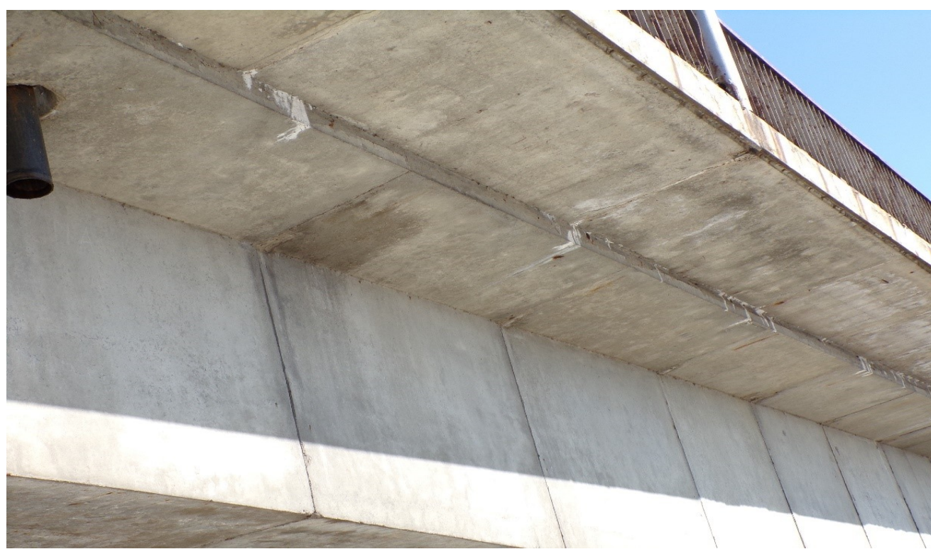
8 pav. Nesandari hidroizoliacija po šaliteljū žemupio pusėje. Perdangos sijos blokų lentynose matyti išsisunkę karbonatiniai produktai
