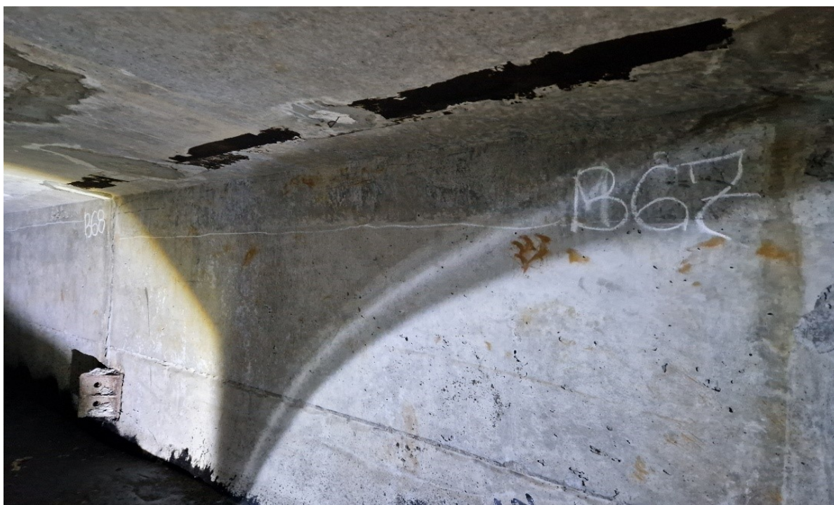
152 pav. „A“ sijos A67 bloko sienutės viršuje, žemupio pusėje, atsivėręs išilginis 0,15 mm pločio plyšys. Plyšys eina per visą bloko plotį
