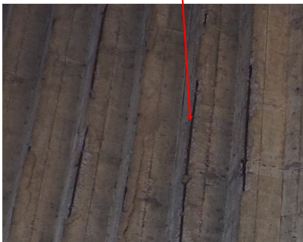
54 pav. Pradedą irti ketvirtos atramos apdaila aukštupio pusėje, pleišėja ir trupa apsauginis betono sluoksnius, koroduoja į paviršių išlindę išilginės armatūros strypai
