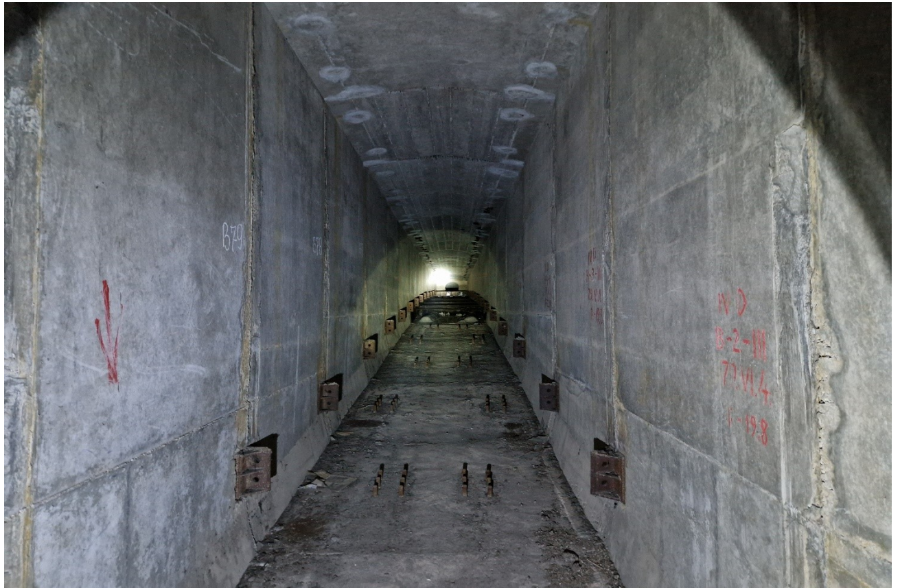
223 pav. „B“ sijos blokų sienutėse žiūrint nuo B79 bloko link III tarpatramio perdangos vidurio matyti vandens tekėjimo žymės
