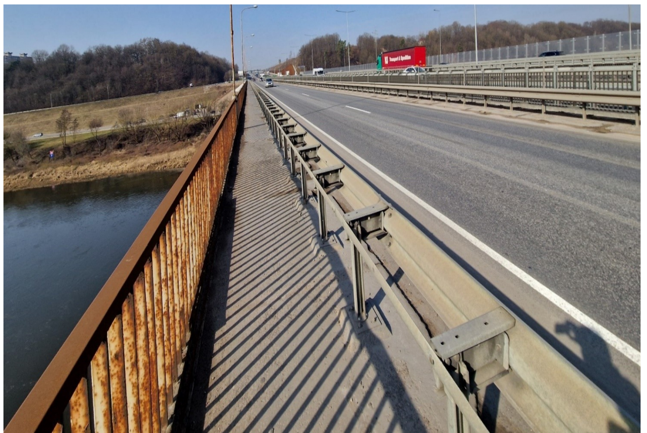
21 pav. Apšvietimo stulpų bendras vaizdas žemupio pusėje. Visi stulpai pažeisti korozijos, dalis jų pavirtę į upės pusę, dalis į kelio pusę
