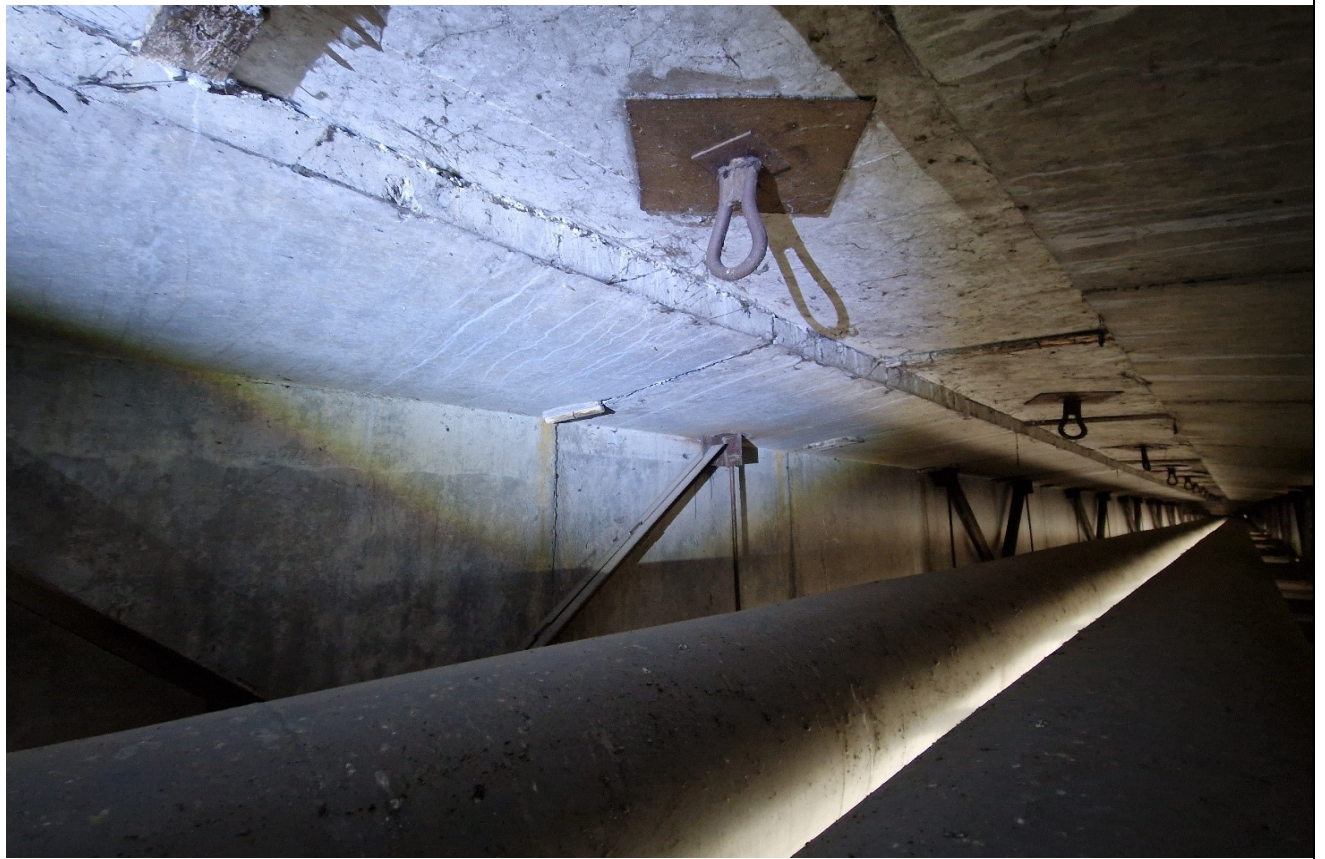
11 pav. Nesandari hidroizoliacija virš perdangos. III tarpatramio perdangos „A“ ir „B“ sijų blokų lentynose matyti karbonatinių produktų tekėjimo žymės
