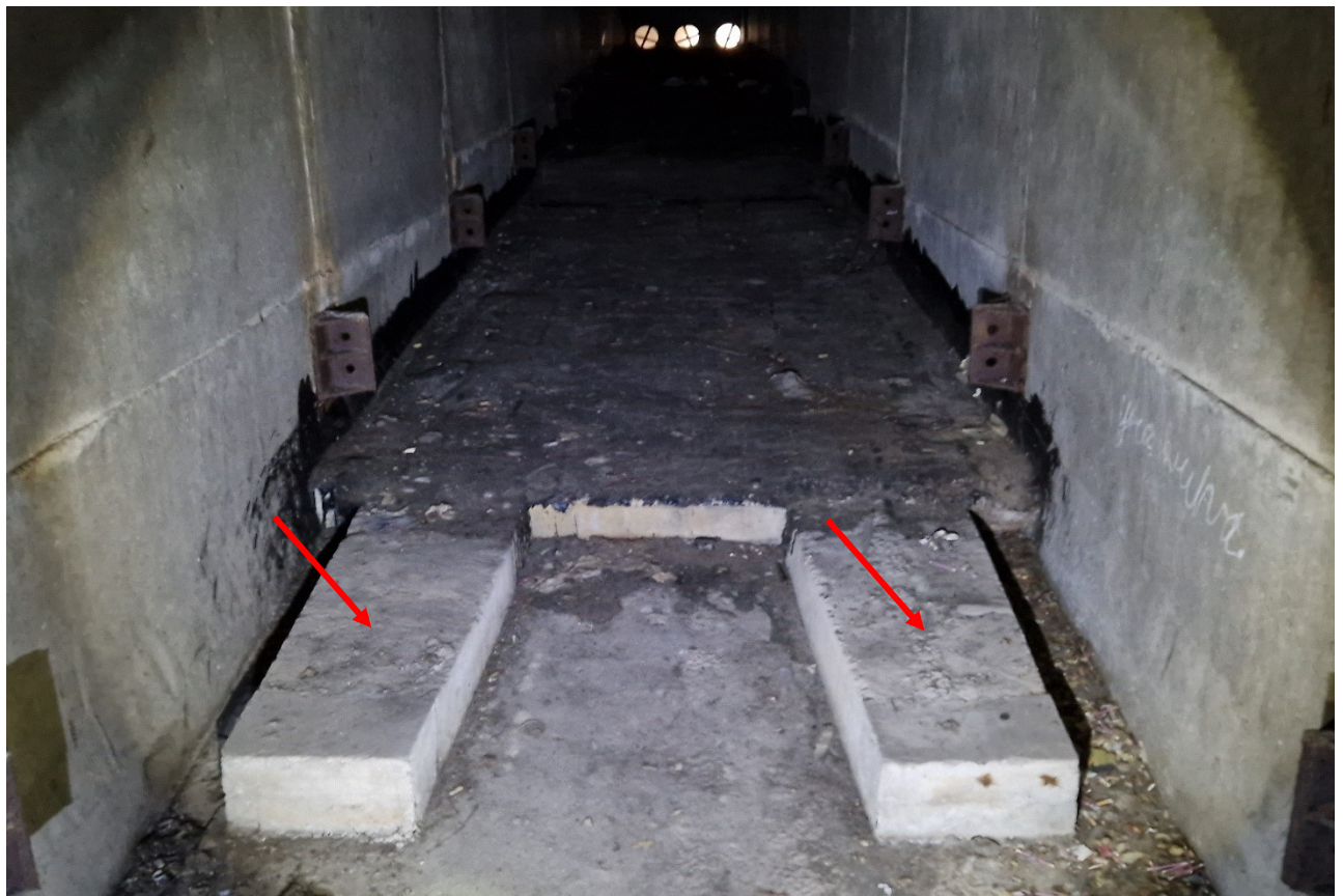
176 pav. Įtemptos armatūros fotofiksacija „A“ sijoje žiūrint nuo A126 bloko. Įtemptos armatūros gniūžčių galai užbetonuoti, tačiau apsauginis betonas apie 1,0 m ilgyje nėra padengtas bitumo mastika
