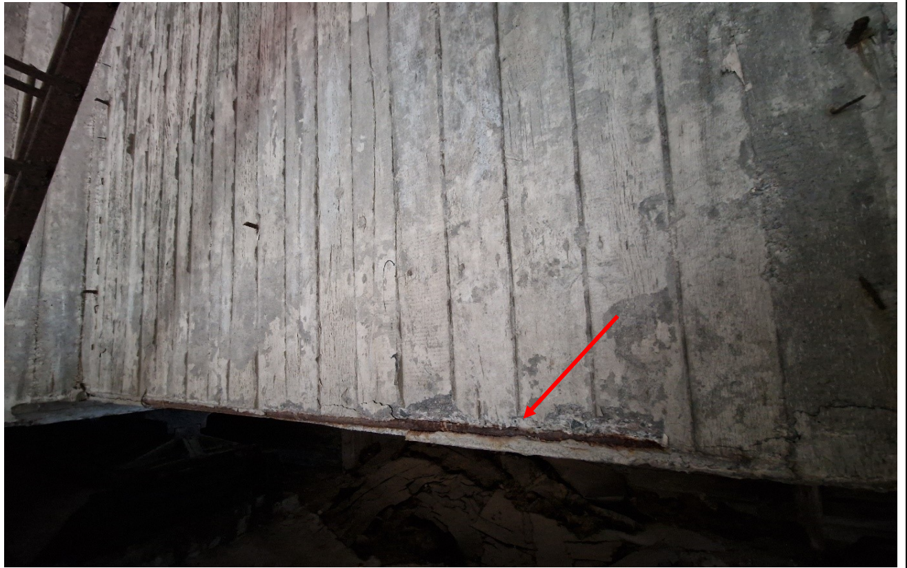
37 pav. Skersinė diafragma tarp „A“ ir „B“ sijų virš V atramos. Diafragmos apačioje atsokęs ir nukritęs apsauginis betono sluoksnis, koroduoja į paviršių išlindę armatūros strypai
