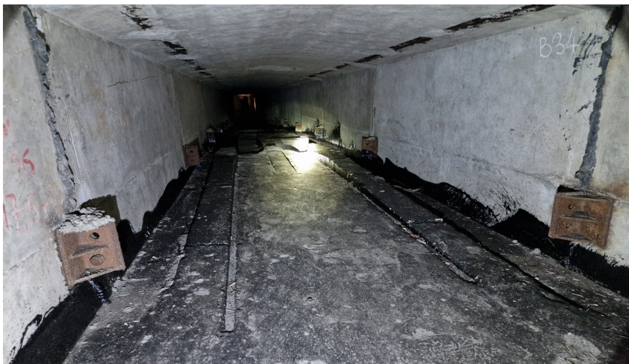
204 pav. Įtempta armatūra „B“ sijos apačioje žiūrint nuo B34 bloko link 4 atramos. Įtempta armatūra užbetonuota ir betonas padengtas apsaugine bitumo danga. Apžiūros metu defektų neužfiksuota
