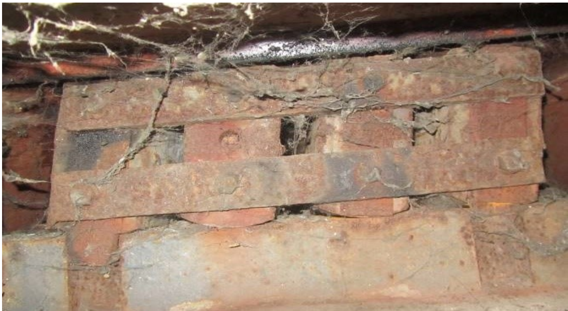
59 pav. Paslankūs atraminiai guoliai virš antros atramos. Guoliai nesutepti, metaliniai elementai pažeisti korozijos
