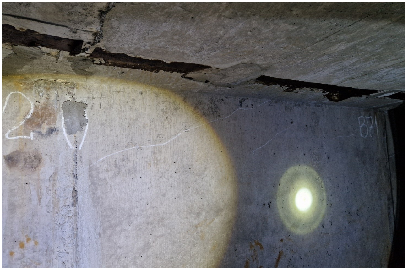
155 pav. „A“ sijos A71 bloko sienutėje, žemupio pusėje atsivėrę įstriži 0,10 mm pločio plyšiai
