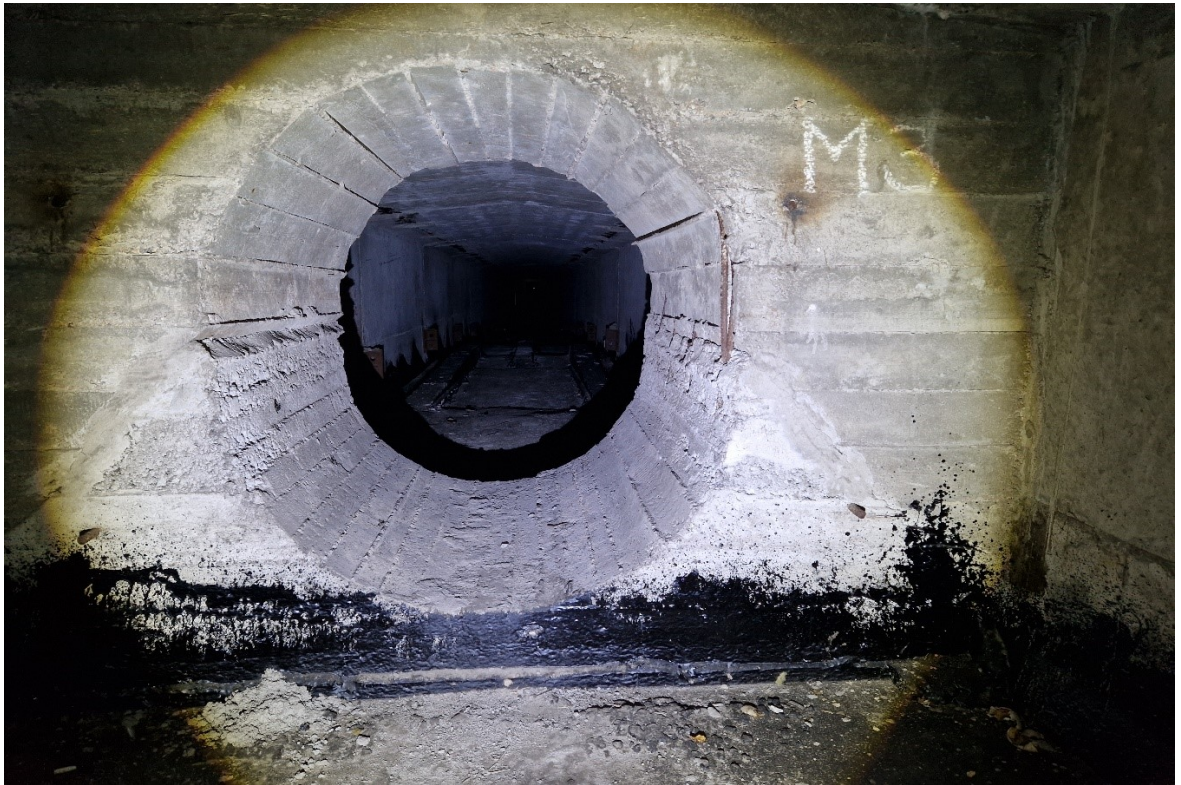
119 pav. Antrojo tarpatramio perdangos viduryje, monolitinės blokų sandūros kraštuose atsivėrę įstriži 0,20 mm pločio plyšiai
