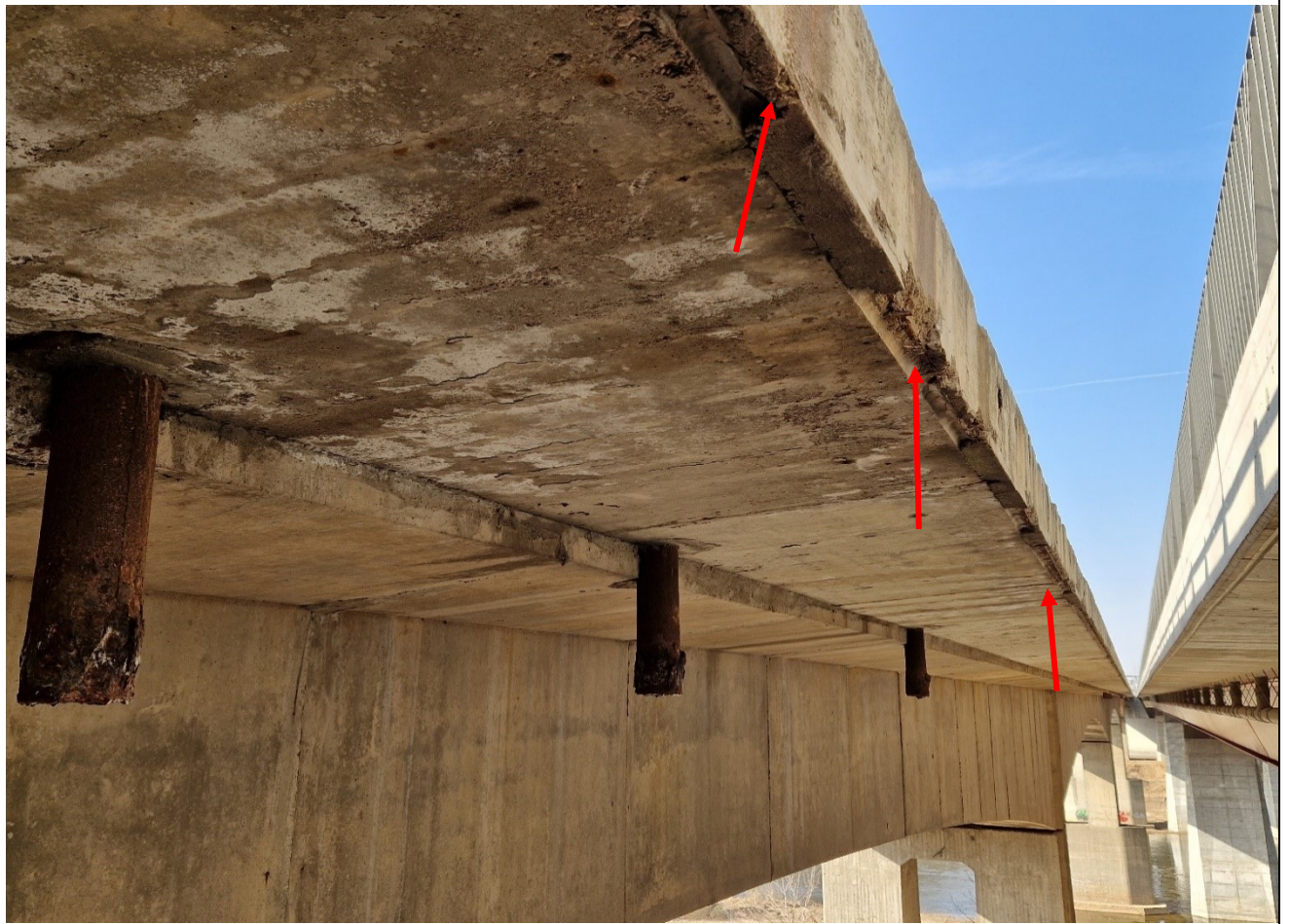
25 pav. Turėkliinių blokų bendras vaizdas aukštupio pusėje. Daugelyje vietų apirusios turėkliinių blokų apačios, lokaliuose vietose stipriai ištrupėjęs betonas
