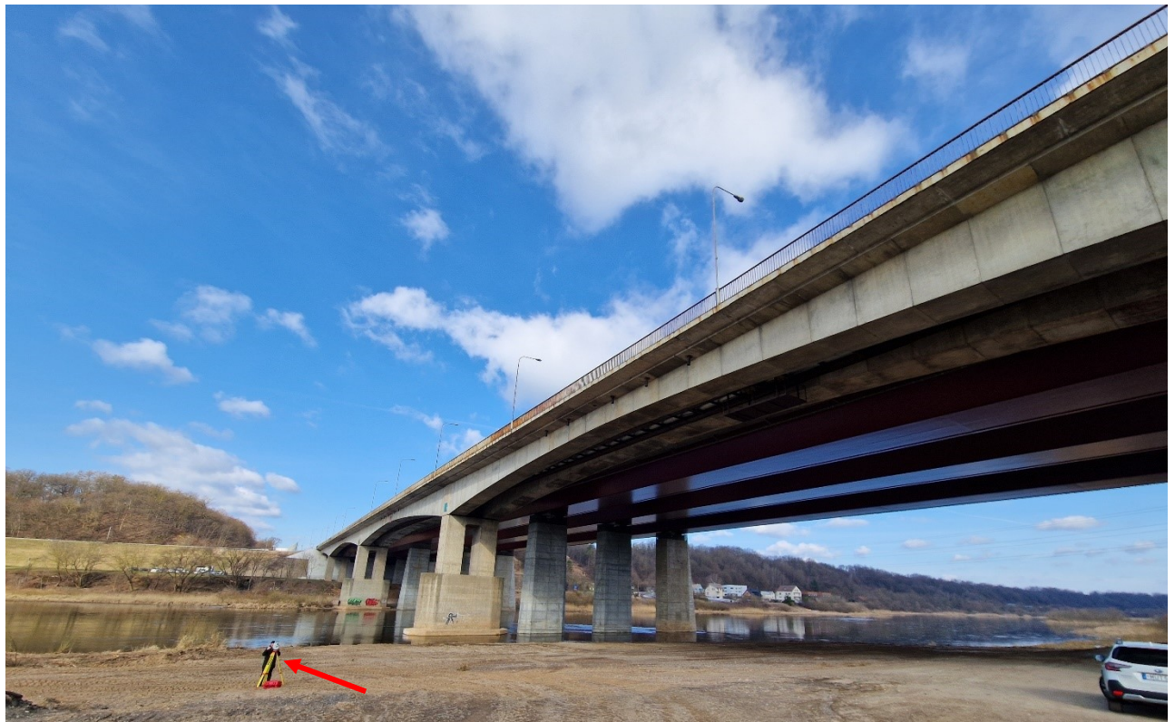
79 pav. Robotizuotas tacheometras po antrojo tarpatramio perdanga
