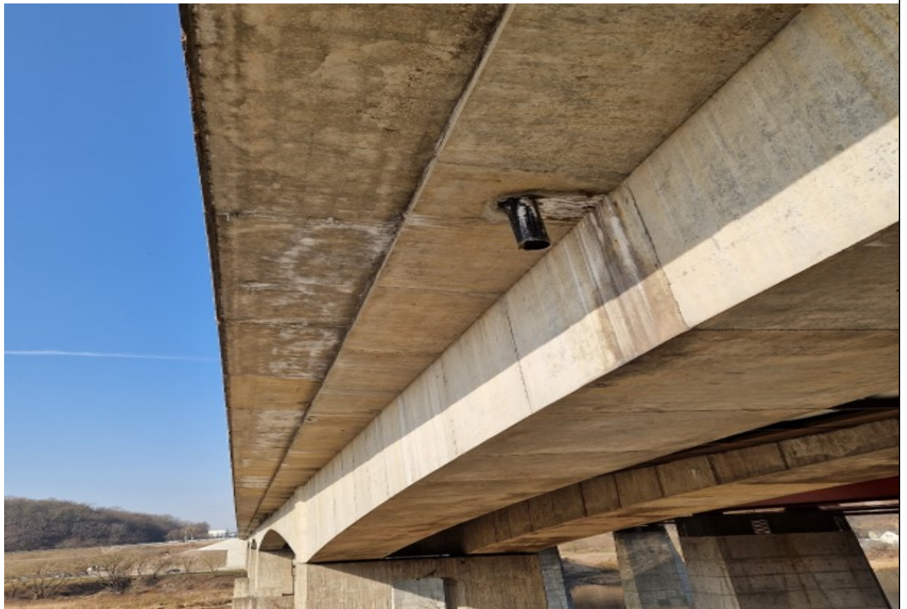
13 pav. Netinkamai įrengta arba neįrengta hidroizoliacija po šaltiličiu ir palei vandens surinkimo ir nuvedimo šulinėlius žemupio pusėje. Šaltiličio plokščių apačioje daugelyje vietų matyti išsiskę karbonatiniai produktai
